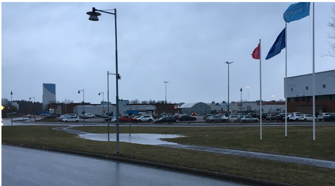
Figur 6-27. Lokal översvämning orsakad av att vatten från regn inte leds ut från området. Februari, 2020.
