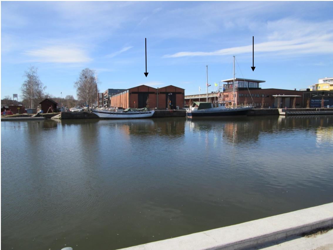
Figur 6-1. Till vänster ses Transitohallarna från 1950-tal för ANA:s billeveranser. Till höger ses Lantmännens förnödenhetsmagasin, med två delar från 1960 respektive 1977, med senare komplettering av takutbyggnad.
