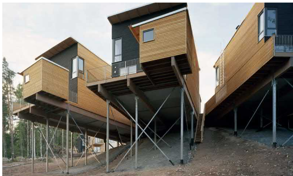
Husen har anpassats till terrängen, här med höga pelare. Källa: Brunnberg & Forshed
