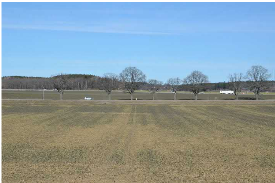
I förgrunden syns Nyköpingsvägen som i öst ansluter till Nyköping och i väst leder genom Bergshammar som vuxit fram runt vägstrukturen. I bakgrunden syns nästa generation av väg, E4. I samma riktning genom landskapet går även södra stambanan.
