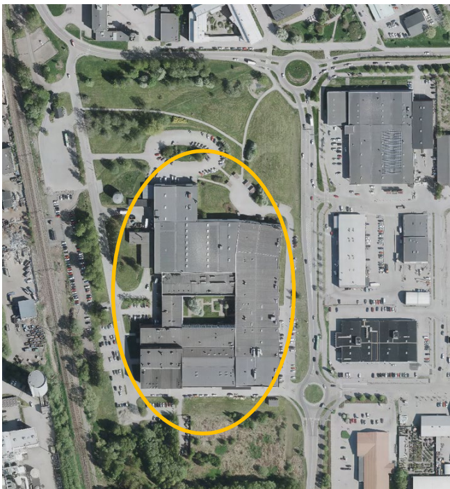
Figur 1 Befintlig bebyggelse på Ribban 5 (inringad).
