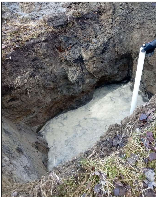
Provgrop 22TF07. Djup 1,8 meter. installation av rör för mätning av deponigas. Filtrets spets är placerad i avfall som är vattenmättat.
