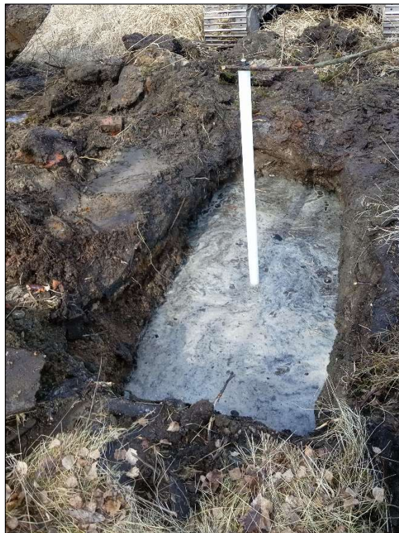
Provgrop 22TF04, installation av rör för mätning av deponigas. Filtrets spets är placerad i avfall som inte är vattenmättat.
