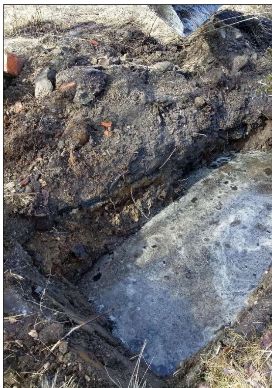
Provgrop 22TF04. Djup 1,4 meter, vatten påträffades 0,7 meter under markytan.
