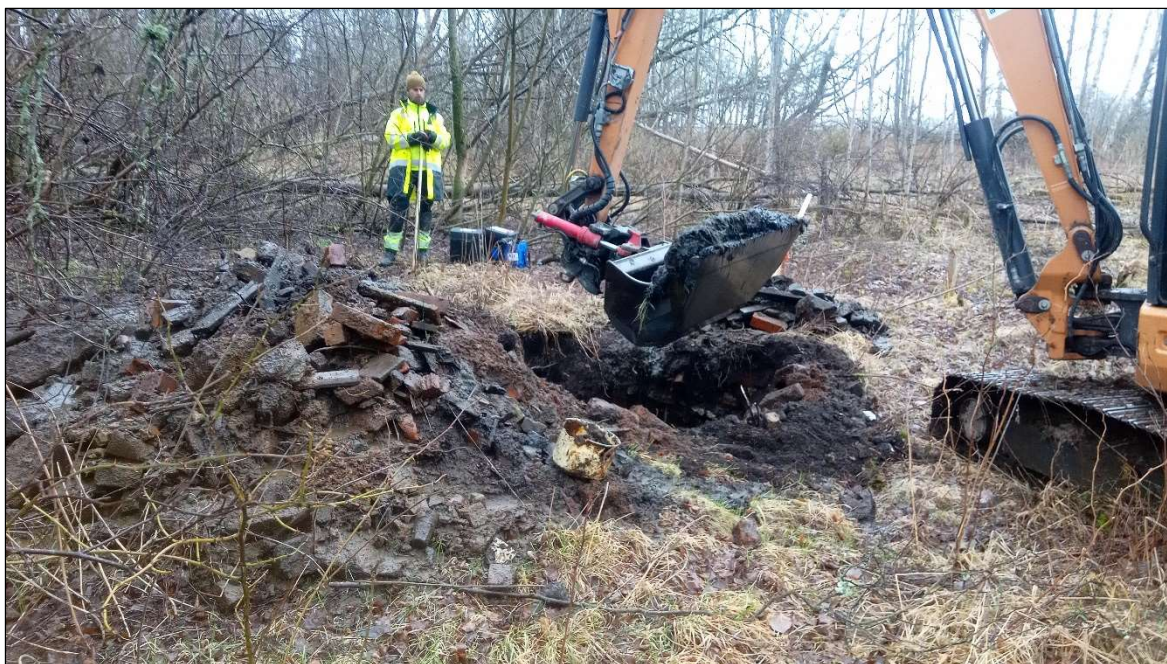
Provgrop 22TF09. Djup 1,1 meter, avfall i mättad zon.
