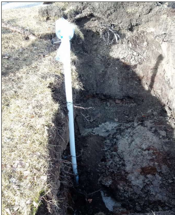
Provgrop 22TF03, installation av rör för mätning av deponigas. Filtrets övre kant 0,6 meter från markytan. Spetsen är placerad i avfall som inte är vattenmättat.
