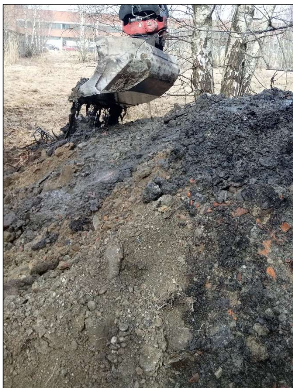
Provgrop 22TF06. Djup 1,8 meter, vattenmättat avfall, vatten påträffades 0,8 meter under markytan.
