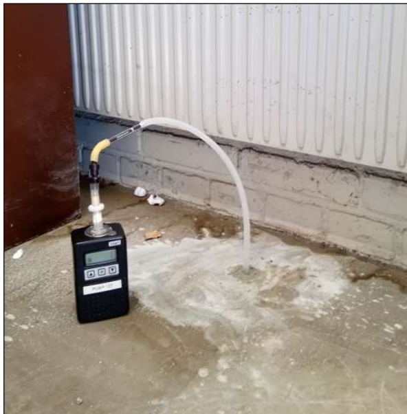
Mätpunkt PL4, pumpad provtagning av porluft under bottenplatta, verkstad EQ Mek.
