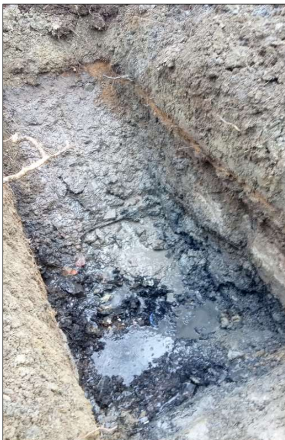
Provgrop 22TF10. Gropens djup 2,0 meter, ca 1,2 meter under markytan finns vattenmättat avfall med oljehinna.
