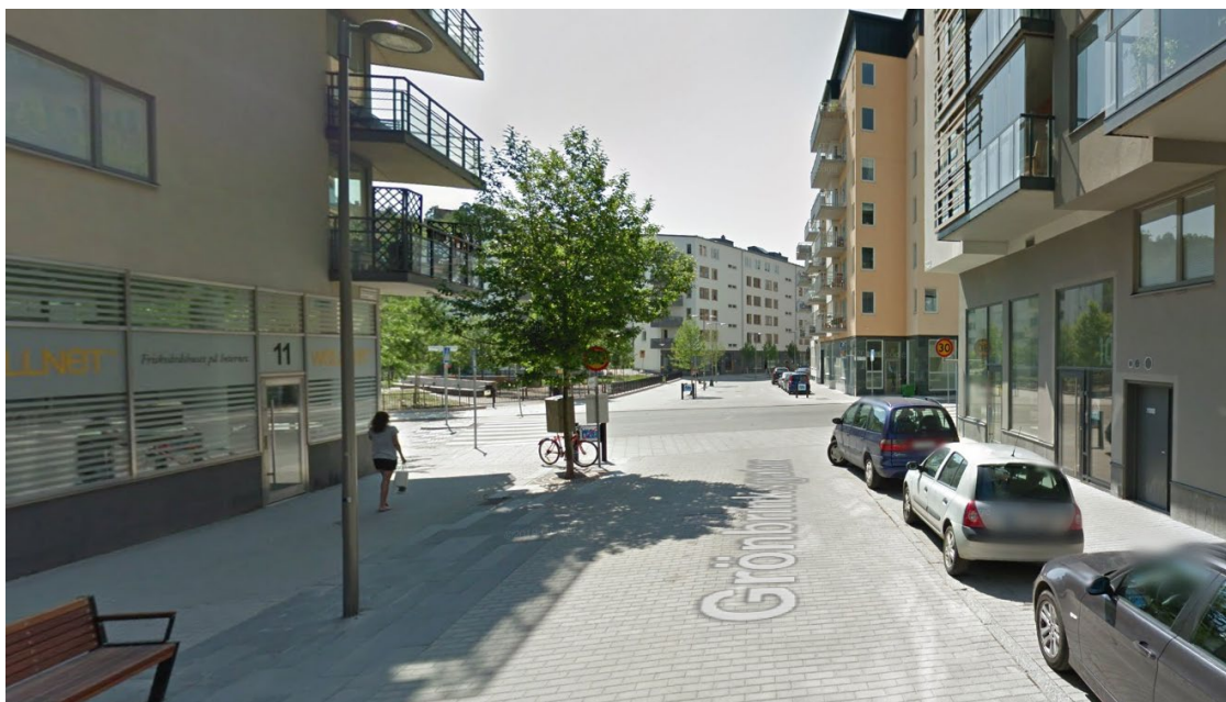
Figur 17. Bilden är ett exempel på när körbana och gångbana utformas utan nivåskillader, med bilparkering/angöring samt en möbleringszon och gångbanor separerat från körbanan. Grönbrinksgatan, Liljeholmen, Stockholm. Källa: GoogleMaps.
