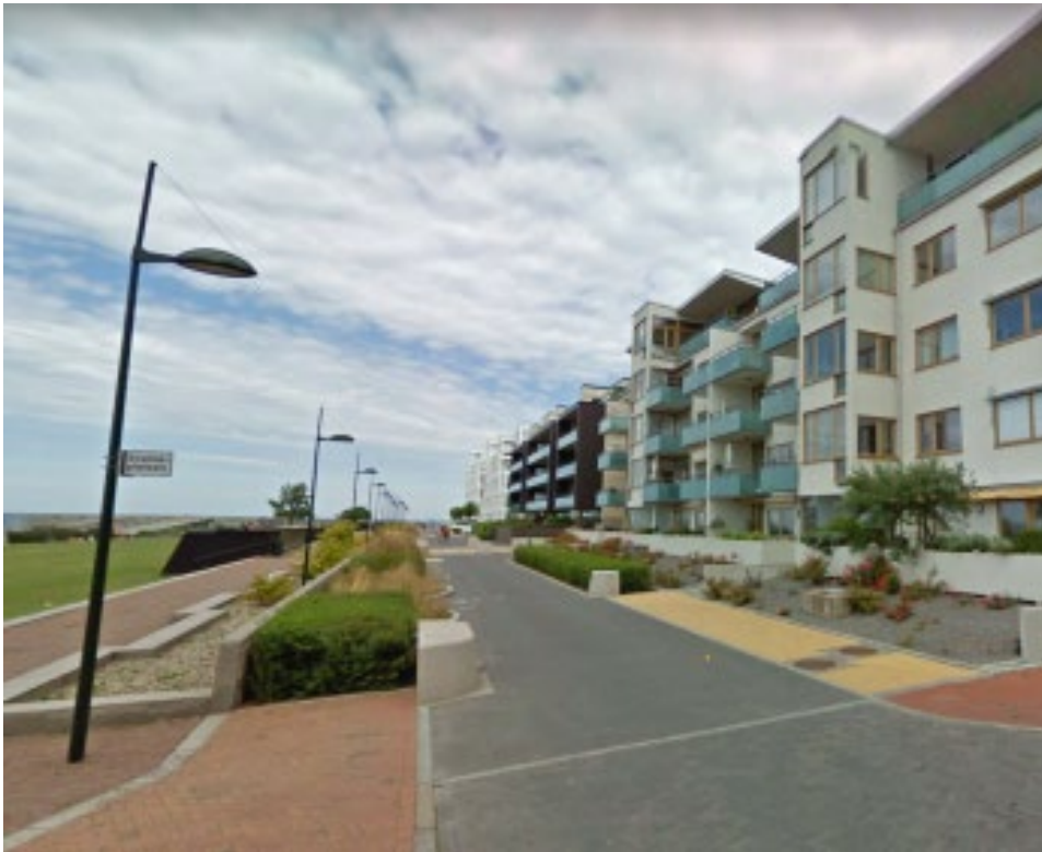
Figur 19. Barometergatan i Västra Hamnen, Malmö. Ett exempel på utformning av en lokalgata.
