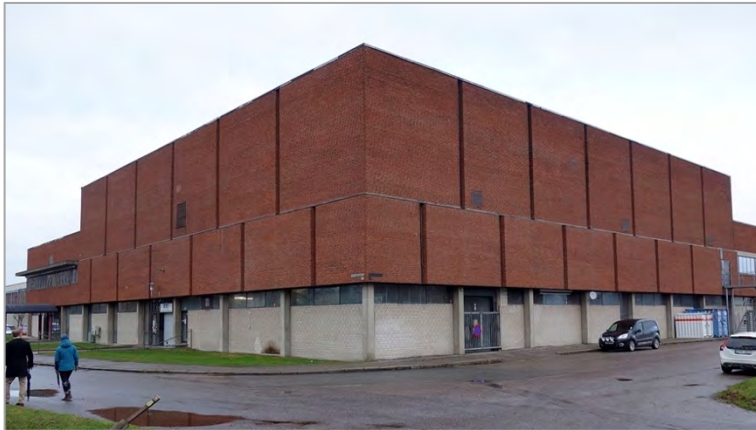
Fabriksbyggnadens ännu välbevarade, karaktärsfulla sydvästra hörn (Ribban 5).
