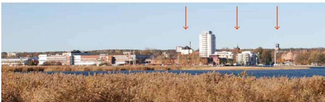
Figur 8, Vy från Arnö in mot planområdet i befintlig situation. Blickpunkt 1b, i enlighet med Kulturmiljöutredningen. Nyköpingshus, klockstapeln och St Nikolai kyrka syns markerade med röda pilar.
