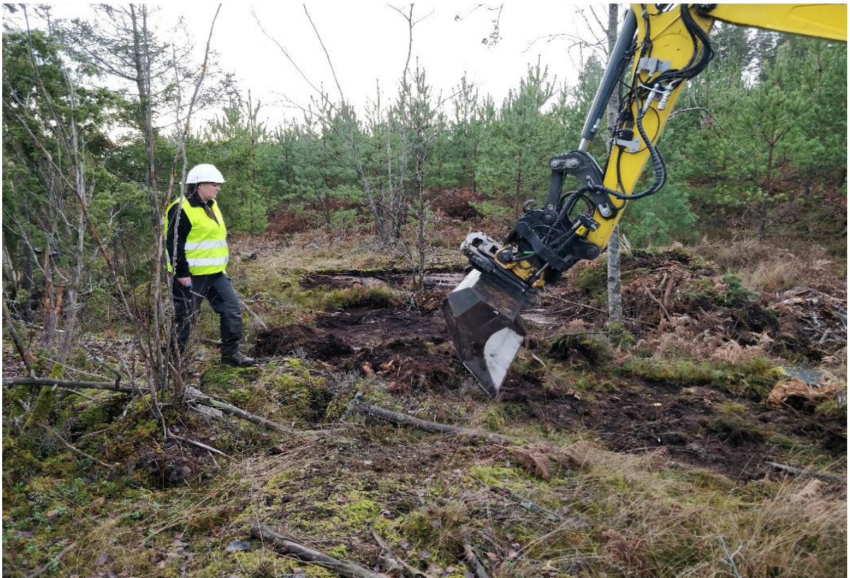
Fig. 4. Sökschaktning med grävmaskin.
