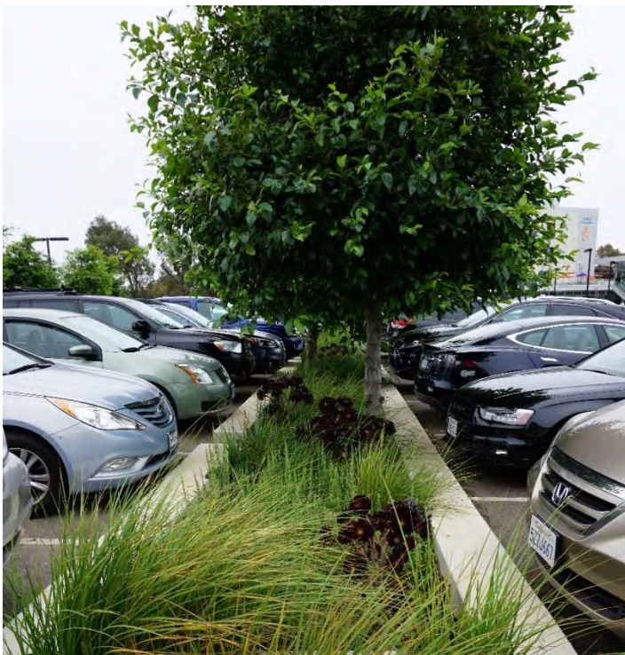
Figur 14 Biofilter mellan parkeringsytor (foto: Maria Näslund)
