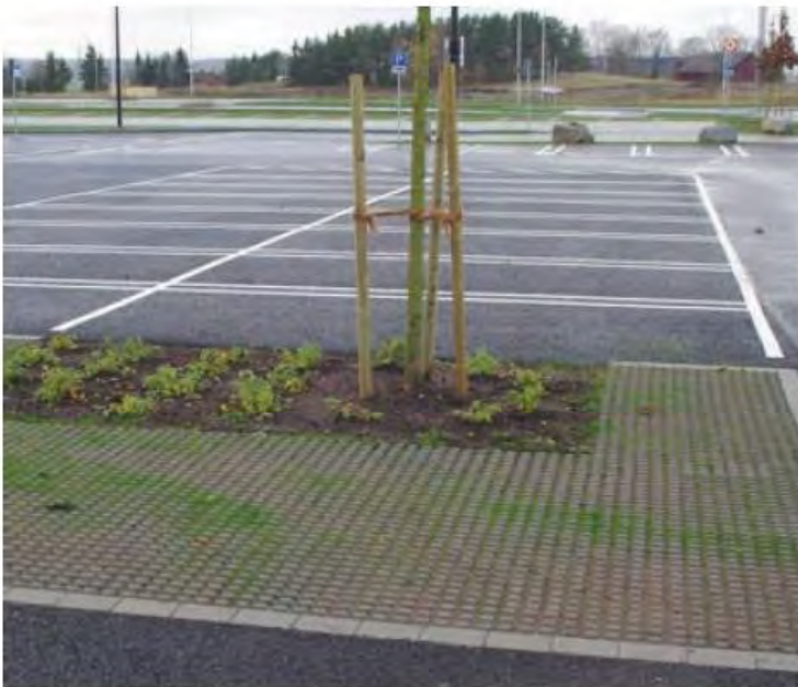
Figur 12 Gräsbevuxen rasteryta samt genomsläpplig asfalt på parkeringsplats (Stockholms stad, 2016a)
