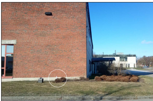
Gammalt GV-rör vid byggnadens nordöstra hörn, norr om entré till Ahlsells. Rördjup 2 meter, inget vatten.
