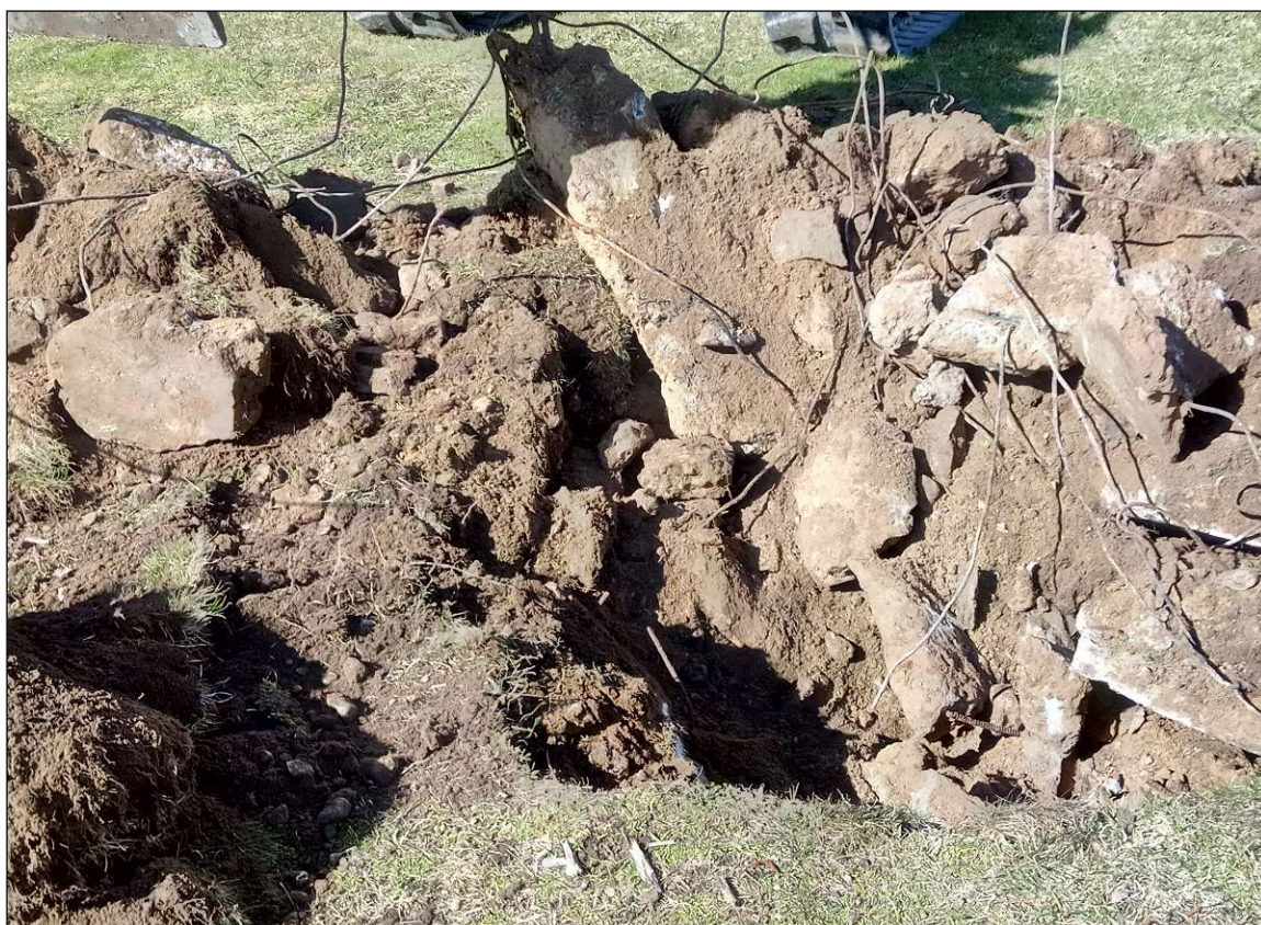
Armerad betong från tidigare byggnad på Ribban 7.
