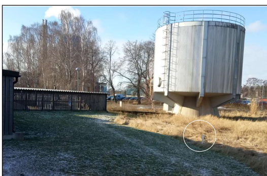
Gammalt GV-rör vid byggnadens nordvästra hörn (XX02). Rördjup 2,05 meter, gvy fr ök rör 1,28. Ej oljefilm på vatten.
