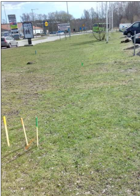
TF19, utgick pga stora kabelstråk i hela ytan.
