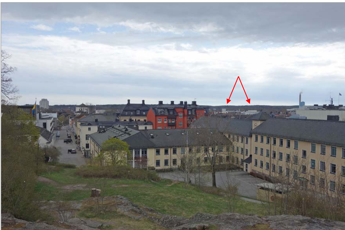
Bild 3. Vy mot söder från Borgarberget. Här syns att den numera ombyggda silon i hamnen, Kungstornet, butiks- och bostadshusen på Storgatan samt värmeverket är de byggnader som tydligast avtecknar sig i siluetten. Enligt bildmontaget bryter inte den planerade bebyggelsen horisonten och den återfinns inte heller i närheten av de historiska landmärkena. Som jämförelse är den högsta byggnaden inom det aktuella planområdet ungefär hälften så hög som silon, 8 våningar mot 16. Avståndet mellan Borgarberget och den föreslagna byggnaden är därtill längre.
