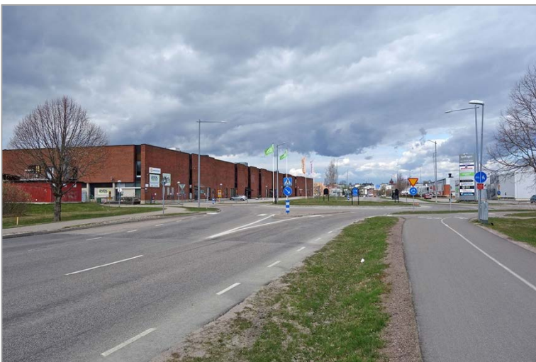
Den östra fasaden har återkommande förskjutningar i muren för att åstadkomma ljusinsläpp, men intrycket och stadsbilden domineras ändå av den 160 meter långa och enhetliga tegelväggen.
