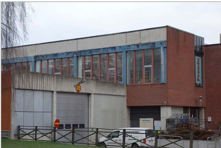
Del av den västra fasaden.
