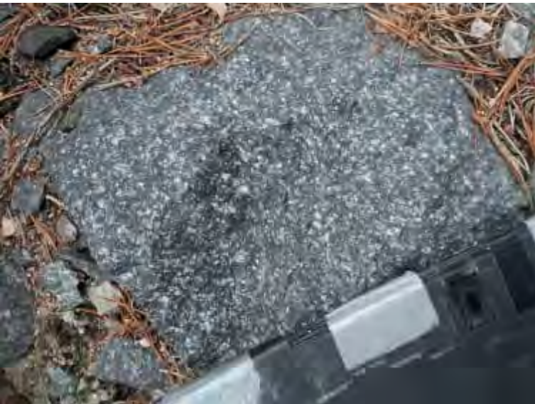
Skärning vid Nyköpingsvägen (4)
