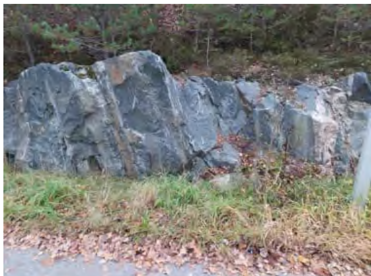
Skärning vid Nyköpingsvägen (11)
