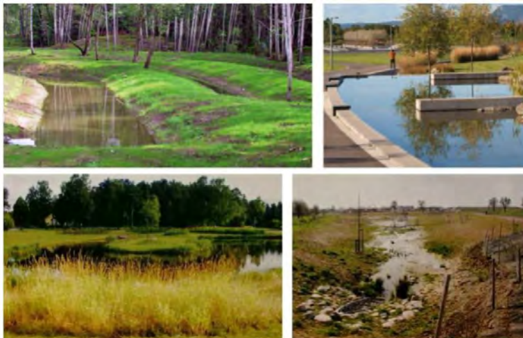
Figur 56. Exempel på dagvattendammar i olika miljöer. (Bildkälla: WRS, Svenskt Vatten).
