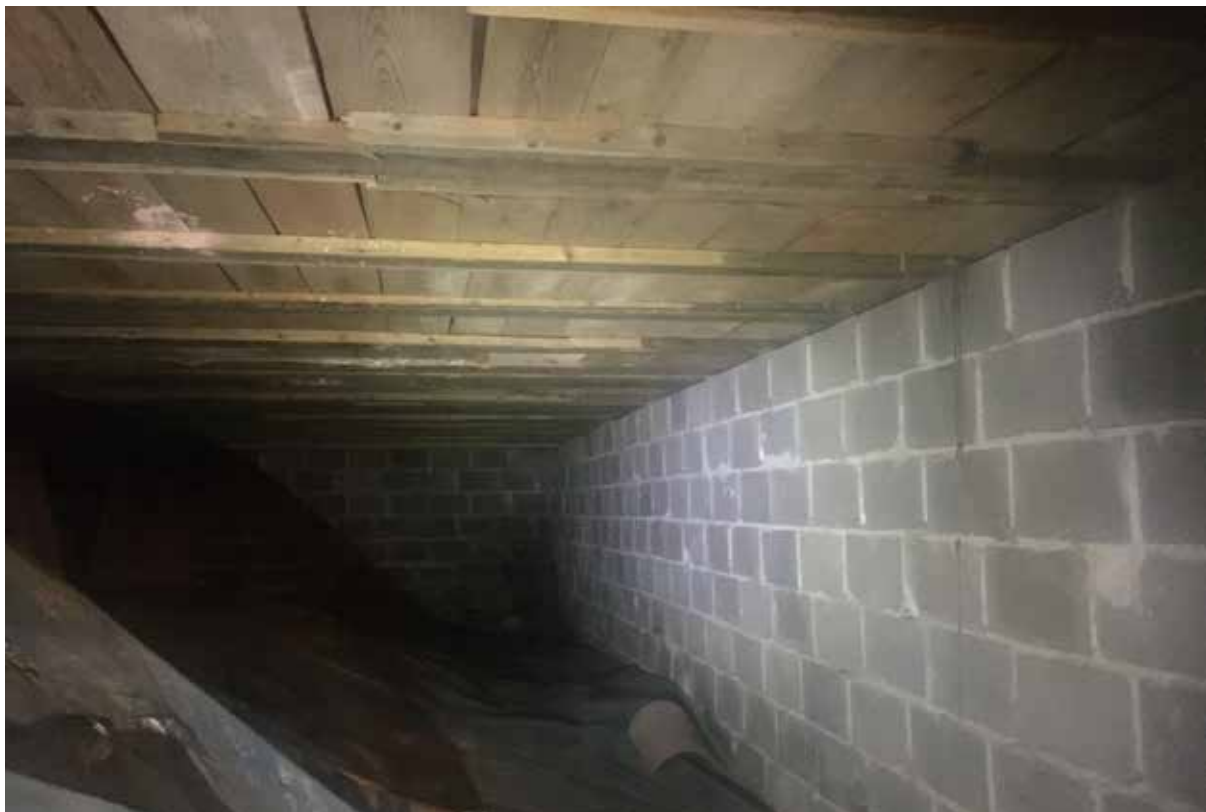
Krypgrunden under 1959 års samlingsal. Golvbjälkarna ligger på grunden. Marken är täckt med plastduk.
