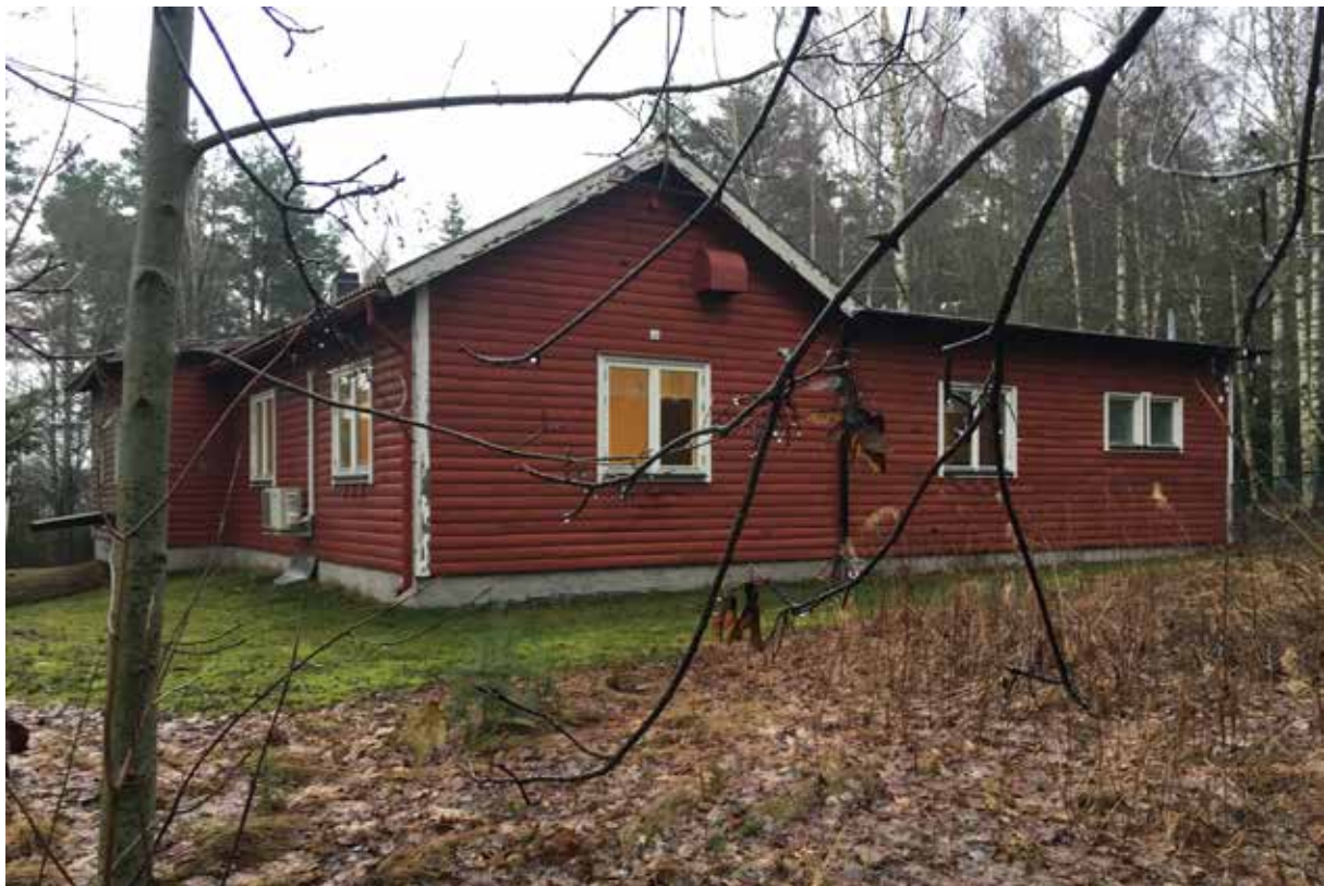
Byggnadens södra sida, på gavelröset sitter ett ventilationsdon. Till höger i bild är 1967 års utbyggnad.
