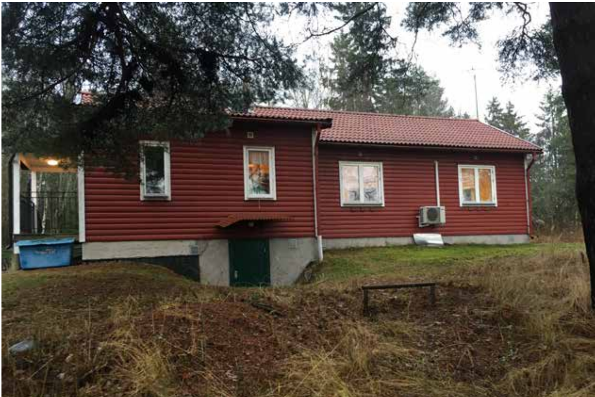
Byggnadens västra fasad med källarnedgång. Lägg märke till att byggnadskroppen är djupare vid källaringången. Längst åt vänster i bild är 1990 års utbyggnad.
