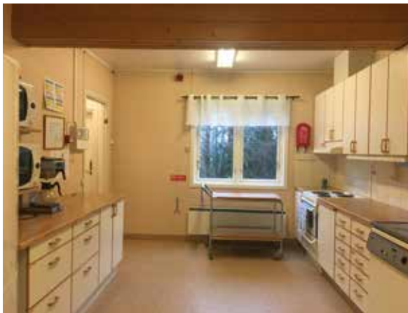
1. Köket, vy mot norr. Notera balken i taket
