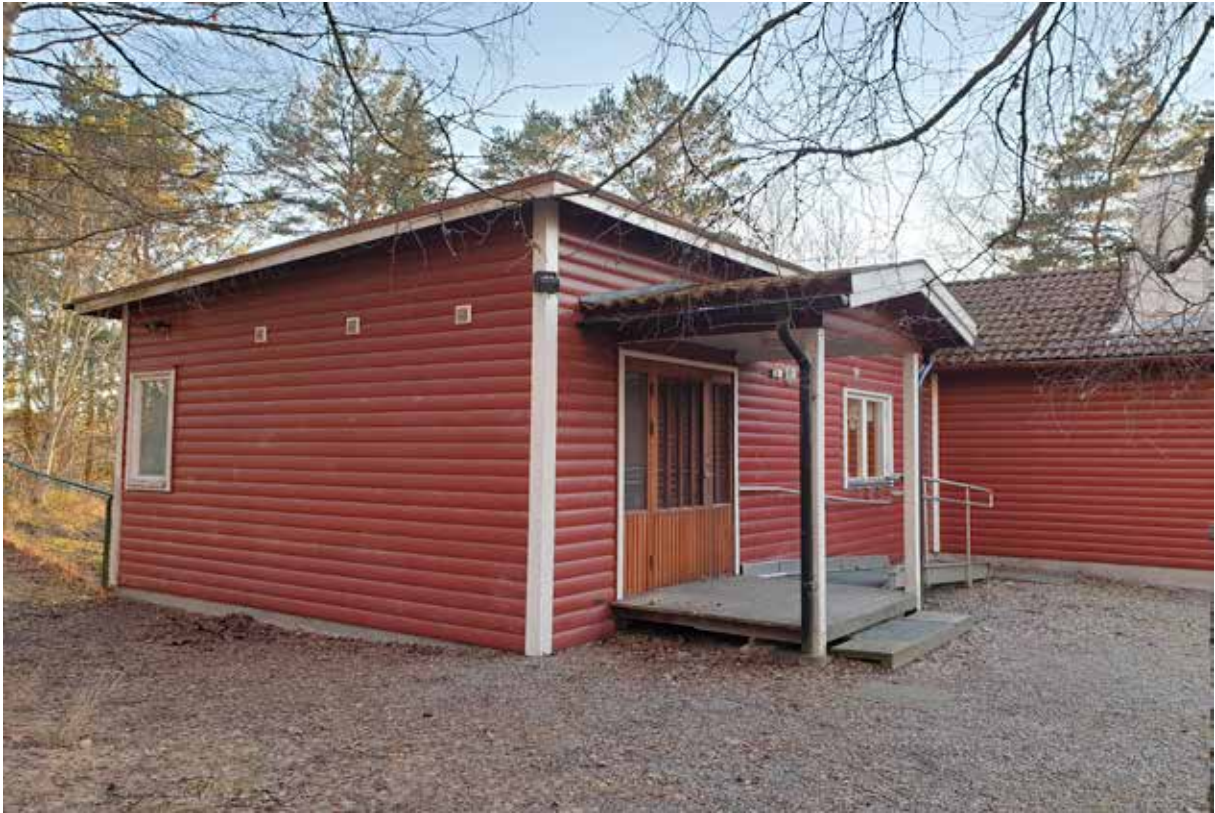
1967 års utbyggnad. Skärmtaket är sannolikt ett senare tillskott, kanske tillkommet i samband med att rampen sattes upp.
