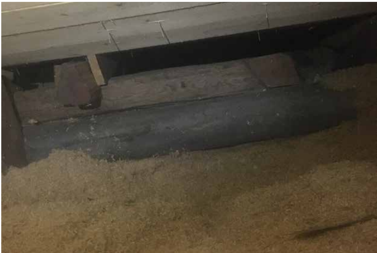
Vinden, mot den västra ytterväggen påträffades några timmerstockar. Dessa verkar dock inte ha något konstruktionsmässigt samband med väggarna. Bedömningen är därmed att de inte utgör väggarnas översta stockar utan timmer som har använts som konstruktionsvirke.
