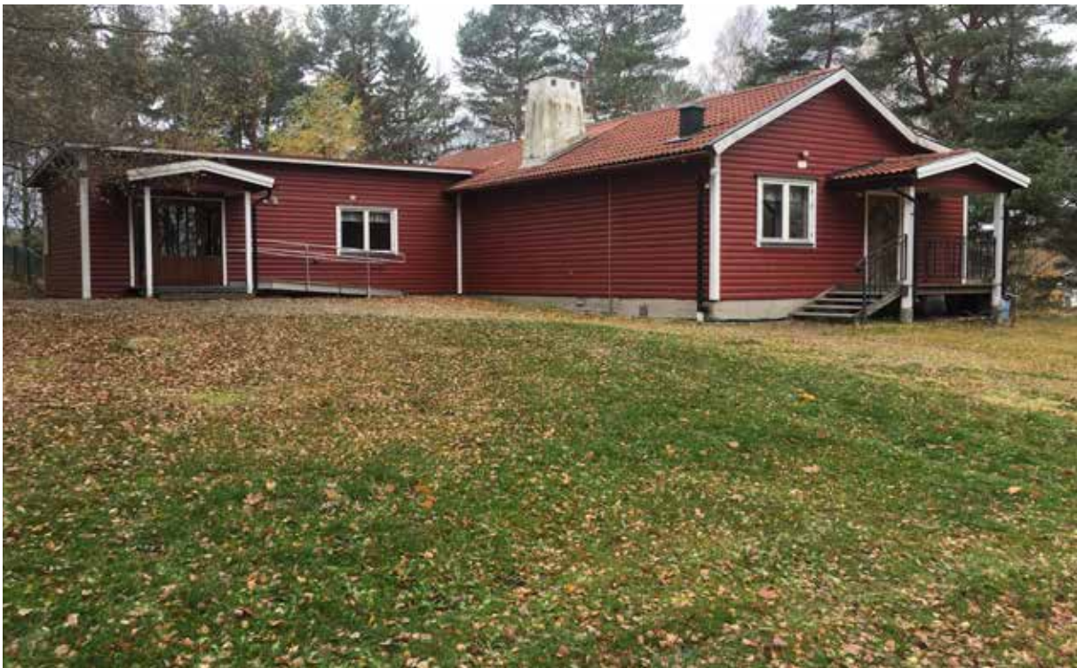
Byggnadens norra entrésida mot gårdsplanen, den del som är till höger i bild är 1959 års byggnad, dock är gaveln utbyggd i linje med det vertikala strecket mellan skorstenen och ventilationshuven. Skorstenen är från 1959 men den befinner sig i den del av huset som kan bestå av återanvänt material från sockenstugan. Till vänster i bild är 1967 års utbyggnad.
