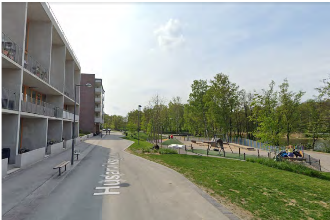
Figur 23. Bilden är ett exempel på när köryta och gångyta utformas utan nivåskillnader intill en parkmiljö. Gatan ger också möjlighet för en smal möbleringsyta för bänkar och belysning, samt separerad gångzon. Husarviksgatan, Norra Djurgårdsstaden, Stockholm. Källa: GoogleMaps.
