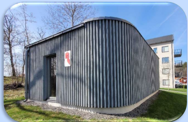
Bild 6 Vädertskyddad cykelparkering i komplementbyggnad på gård. Foto: Labeat Bickaj
