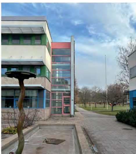
Figur 23 Exempel på den systematiska färgkodningen i trapphus och horisontella fönsterband, Wsp.
