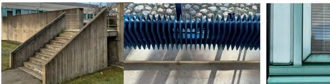
Figur 22 Exempel på konstruktioner med blottad skivgjuten betong och aluminiumpartier i klara brännlackerade kulörer, Wsp.
