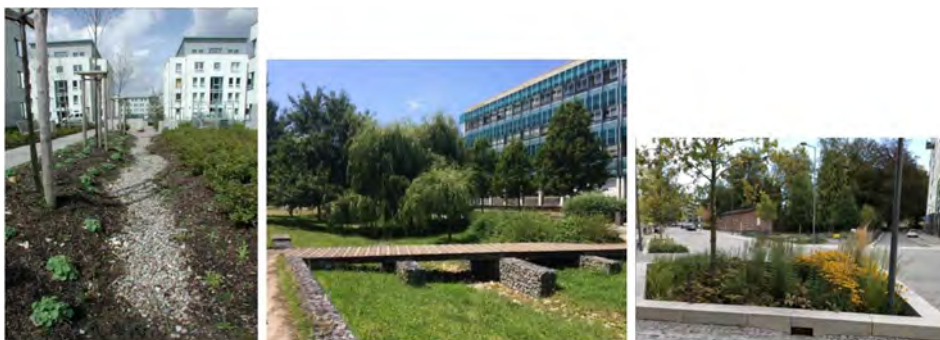
Figur 35 Bilder av möjliga tekniska lösningar för dagvattenhantering som föreslås för kvartersmarken i dagvattenutredningen: makadamdike (till vänster), öppet dike (mitten) och regnbädd (till höger), Norconsult.
