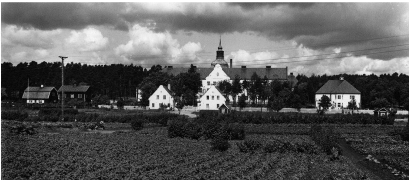
Foto från ca 1920 som visar det nya lasarettet ritat av Ernst Stenhammar. Den uppodlade marken i förgrunden togs snart där-efter i anspråk för villabebyggelse åt lasarettets personal. Villan t.v. med vita fönsterluckor ritades av den välkände arkitekten Isak Gustaf Clason som en prototypbostad för egnahemsgårdar inför lantbruksutställningen 1914. Källa: Sörmlands museums samlingar. Foto: Gustav Wilhelm Oldenburg
