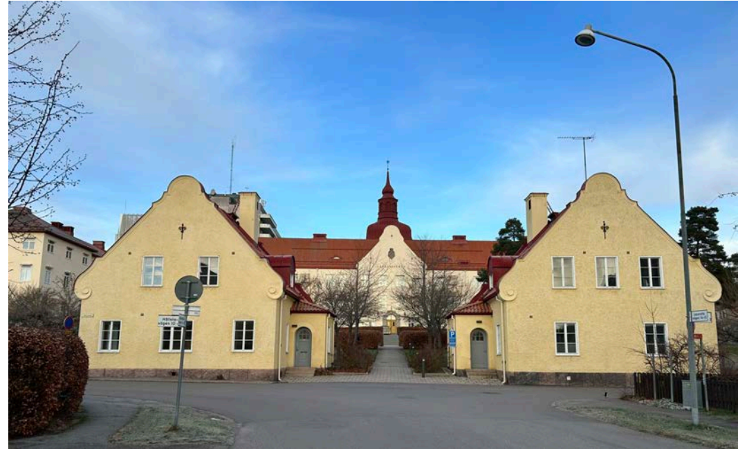
Framför 1914 års lasarett finns de två symmetriskt placerade grindstugorna bevarade. Dessa användes från början bland annat som personal- och vaktmästarbostäder och uppfördes med en arkitektur som motsvarade lasarettets huvudbyggnad.
