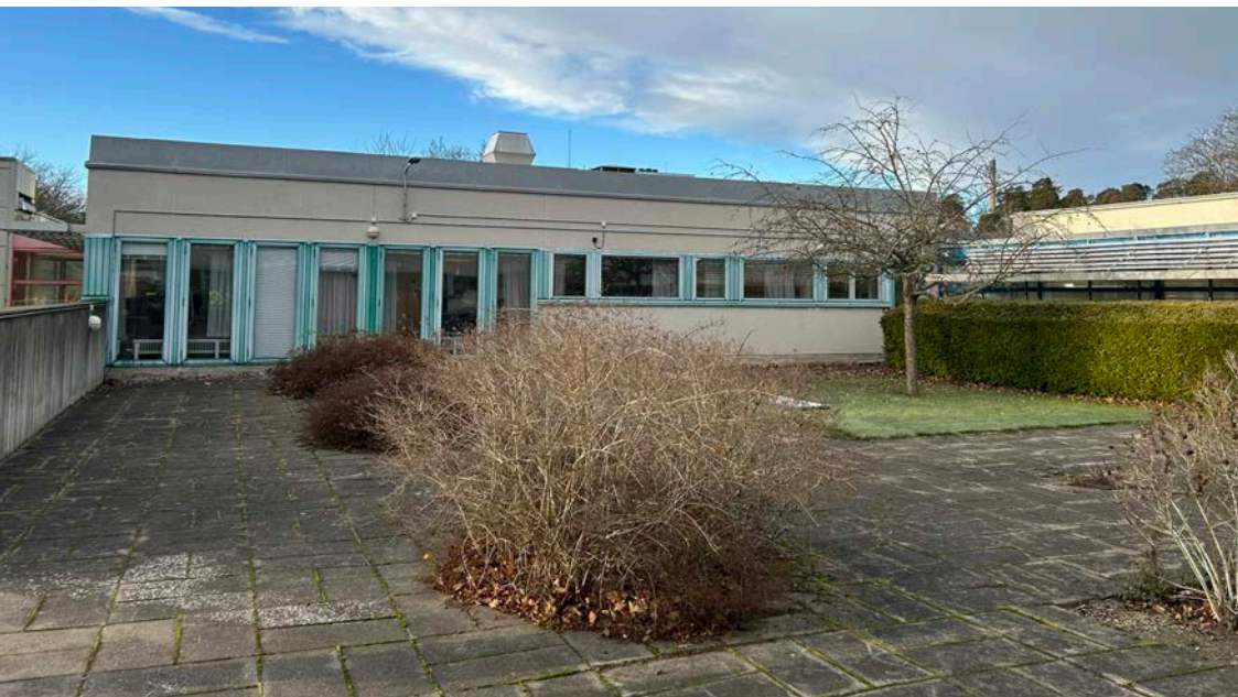
En av de intima innergårdarna mellan de låga vårdpaviljongerna i anläggningens sydöstra del. Växtyterna är förmodligen ursprungliga och har sömlöst integrerats i markbeläggningen. Med tiden har betongplattorna mörknat och markytan blivit ojäm.
