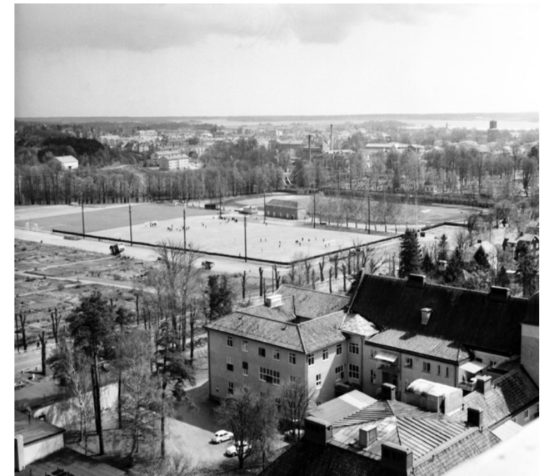
1960-tal. Vy över Brunnsgatan och Folkungavallen från lasarettets nybyggda höghus. Idrottsplatsen bredde vid den tiden ut sig över en större yta och rymde flera fotbollsplaner. Källa: Sörmlands museums samlingar
