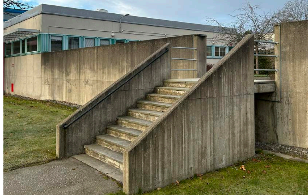
Anläggningens terrasser med trappartier är integrerade i byggnadskropparnas fasader och har en brutalistisk prägel med synliga spår från skivgjutformarna. Den fristående trappdelen och ledstänger/räcken med stålårsprofil är en arkitektonisk fines. Betongen tycks över lag ha varit av god kvalitet.
