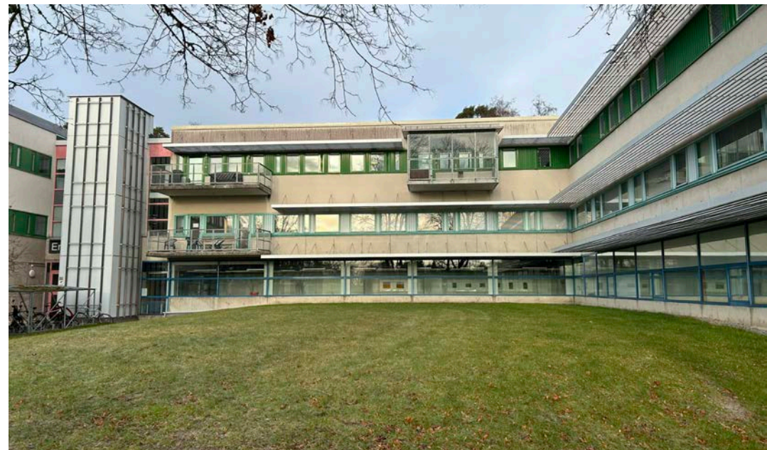
De låga horisontella fönsterbanden är karaktäristiska för arkitekturen under sent 1960- och 70-tal. Solskydden ovanför är ett senare tillägg, liksom inglasningen av balkongen. Det översta gröna fönsterbandet med kraftig kulör har sannolikt renoverats på senare tid. Histornets spaljé är ny.
