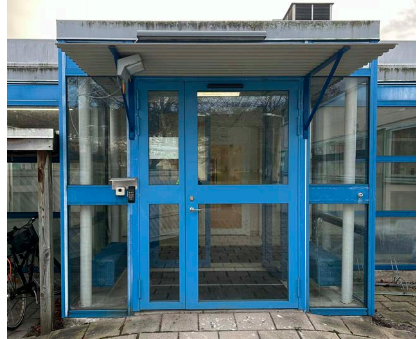
Blått ingångsparti. Interjörens radiatorer har lackerats i matchande kulör. Glaspartierna är förmodligen ursprungliga medan dörren är troligtvis utbytt. Skärmtaket har en mycket en enkel konstruktion som även den kan vara ursprunglig.
