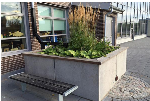
Figur 7-2. Upphöjd regnbädd ovan mark som även kan användas för till exempel plantering eller odling (Bara Mineraler 2019).
