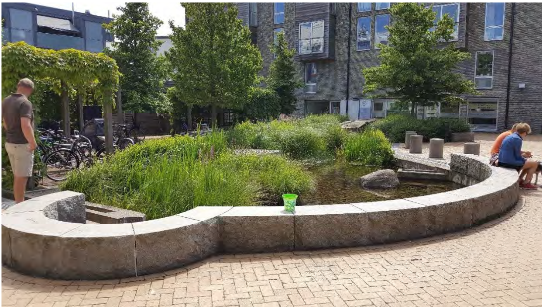
Figur 8-31: Visar ett exempel av en växtbädd, där vattnet samlas för att sedan rinna vidare ut i område med multifunktionell yta. Foto: Structor
