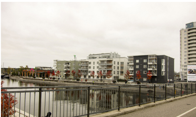
Den norra delen av västra hamnen bebyggdes med företrädesvis bostäder i början av 2010-talet.
