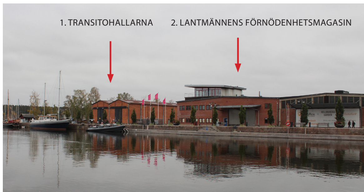
Hamnmagasinen med karaktäristiska fasader mot kajen.
