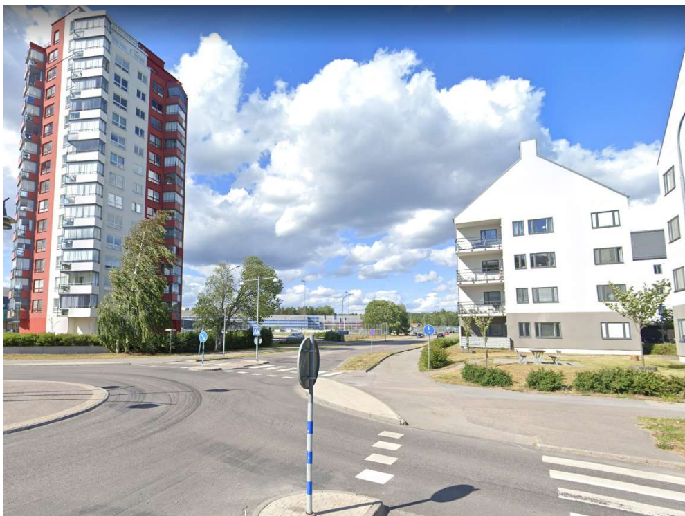
Nuläge från Idrottsvägen, norrut. (bild från Google)
