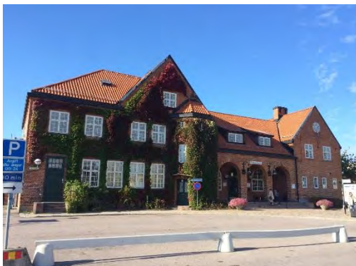
Figur 31. Stationshuset. Foto Swecoo.
