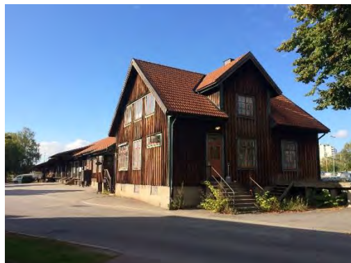
Figur 32. Godsmagasinet. Foto Sweco.
