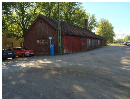
Figur 33. Lokomotorstallet. Foto Sweco.
