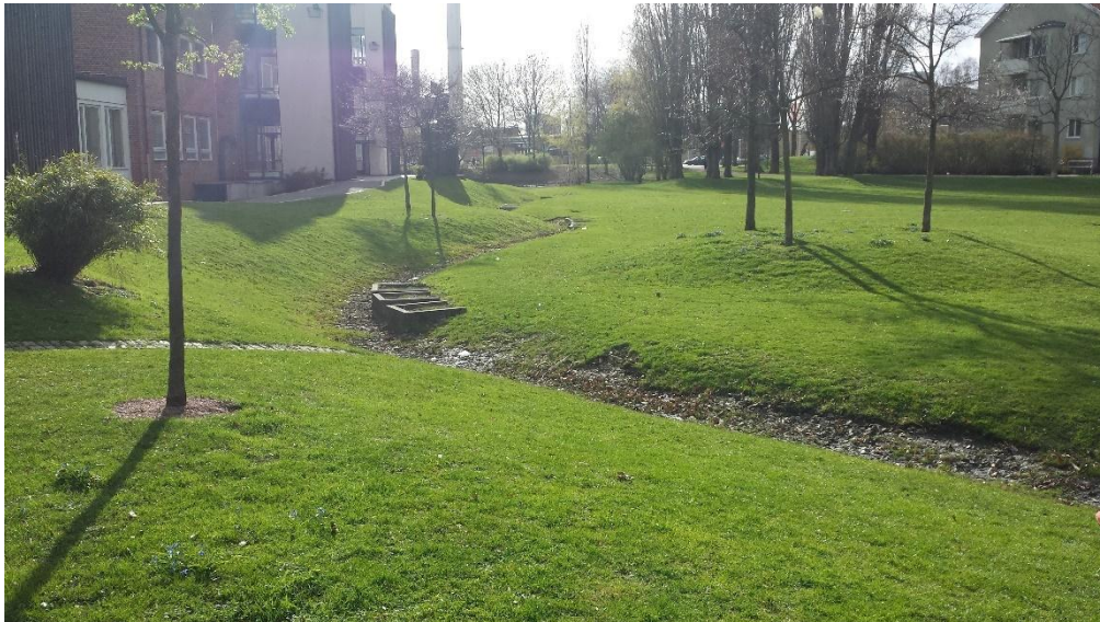
Figur 30. Exempel på svackdike som kan svämma över i ett parkområde.
