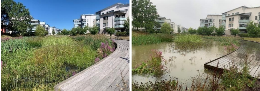
Figur 24. Exempel på dagvattendamm under torra och våta förhållanden, bilder tagna med en veckas mellanrum.
