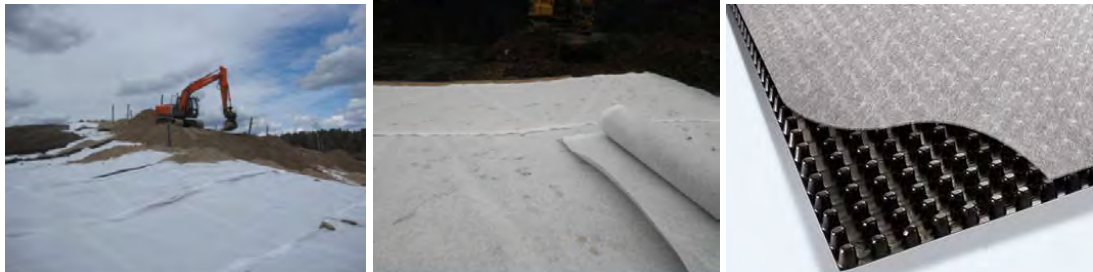
Figur 19. Illustration av dräneringsskikt bestående av dräneringsmatta som dräneringsskikt (Pozidrain längst till höger).
