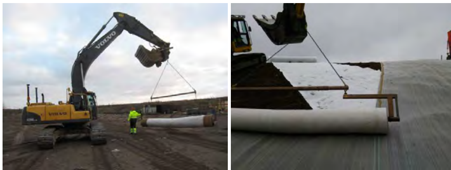
Figur 18. Illustration av utrullning av bentonitmatta med rullokl.
