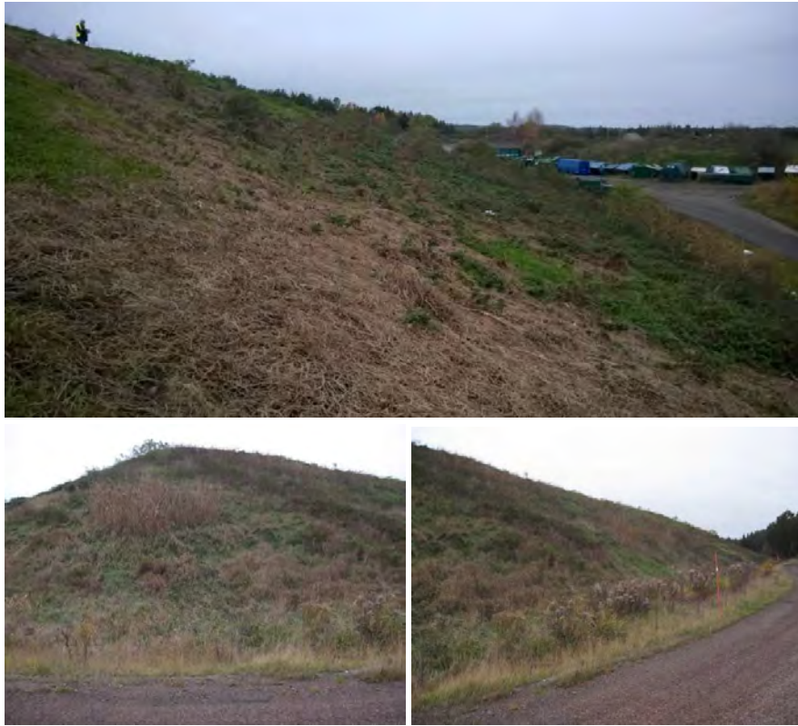
Figur 10. Illustration av släntlutningar brantare är 1:3 (foton tagna 171101).
