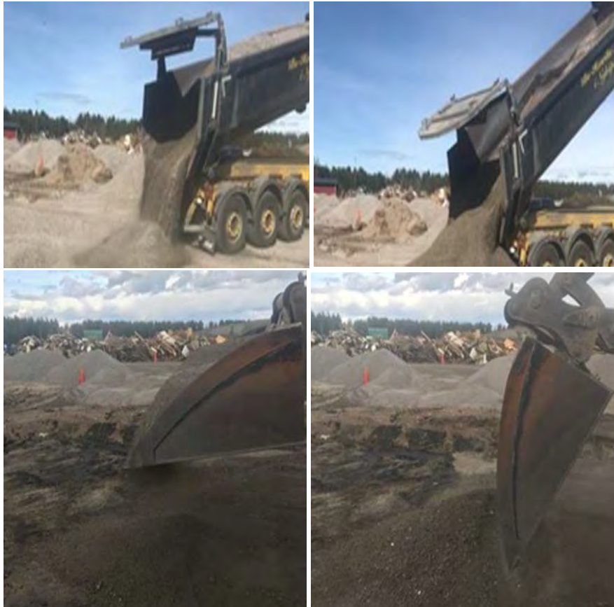
Figur 39. Urval av foton som illustrera att slaggrus ej dammar.
