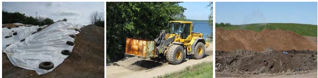
Figur 38. Illustration av plast över flygaska (vänster), bevattning av väg med vattentank (mitten) och bevattning av bioflygaska med sprinkler (höger).
