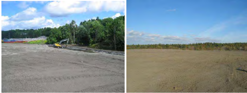
Figur 15. Fyra olika deponier avjämnade med pannsand/slaggrus (övre vänstra), schaktmassor (övre högra), slaggrus/aska/schaktmassor/tegel (nedre vänstra) och aska/pannsand (nedre högra).
