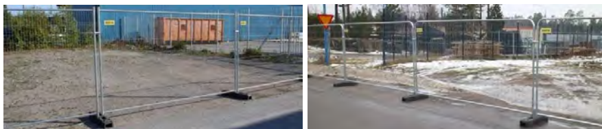
Figur 40. Illustration av byggstängsel i sektioner.
