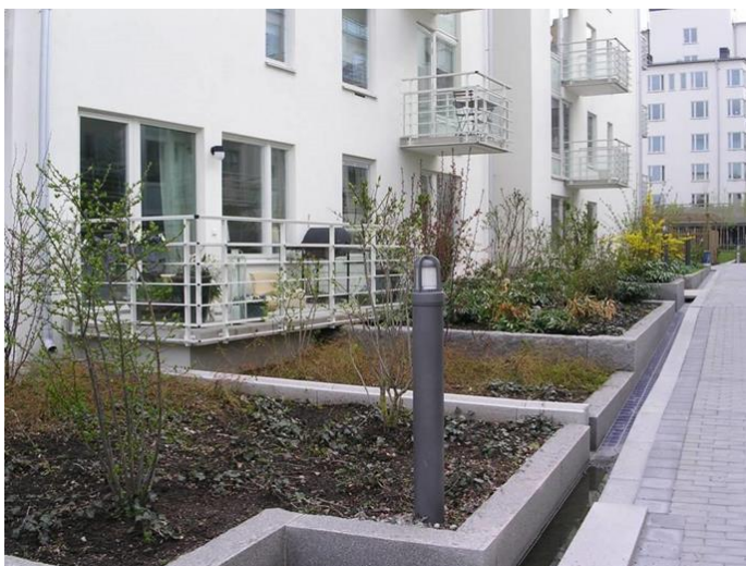
Figur 21. Växtbäddar i anslutning till fasad i Hammarby Sjästad. Foto: Sweco.
