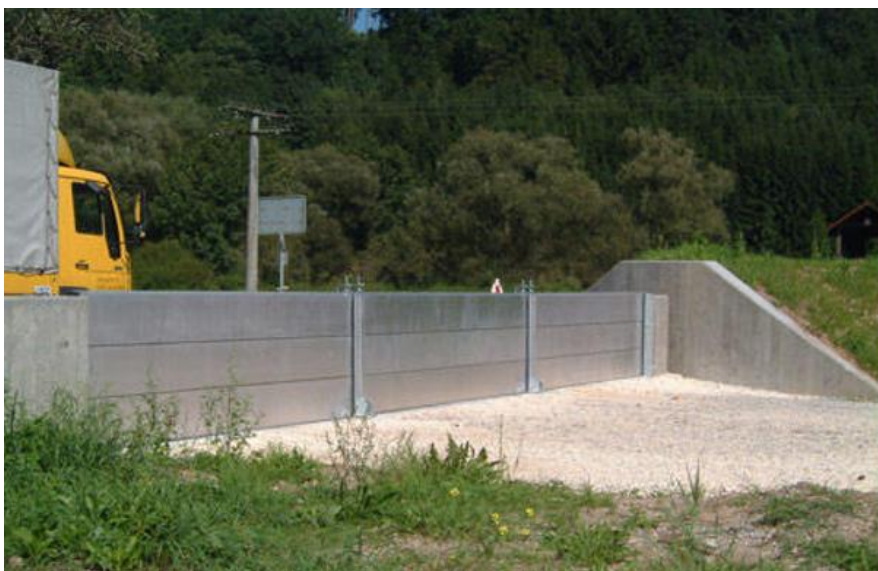
Figur 28. Skyddsåtgärd som kan installeras i mindre skala än visat framför garageinfarter och ingångar vid situationer där höga flöden eller havsnivåer tillfällig uppkommer. Skyddsmuren kan köras ut vid behov för att stänga flödesvägen in i ingångar och garage.
