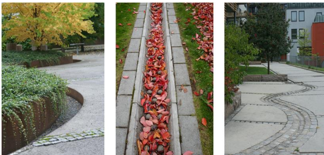
Figur 20. Exempel på hur dagvattenrännor kan förhöja det estetiska intrycket av ett kvartersområde och samtidigt möjliggöra avledning av dagvatten. Foto: Sweco.
