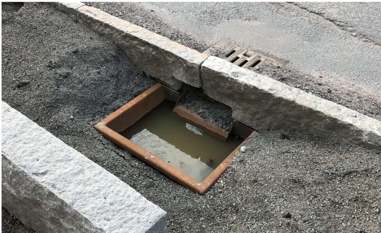
Figur 10. Anläggning av inloppsbrunn till planteringsyta med gallerbetäckning och spridningskär. Foto: A. Thorsell Structor Uppsala AB.
