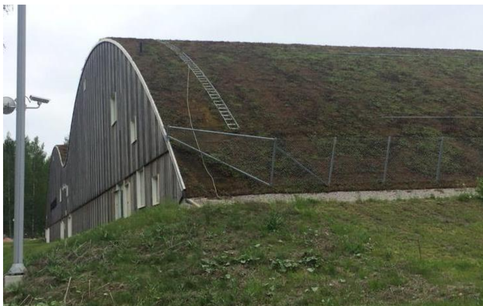
Figur 12. Grönt sedumtak på SEB USIF arena, Uppsala. Foto: E. Hagström, Structor Uppsala AB (2016).
