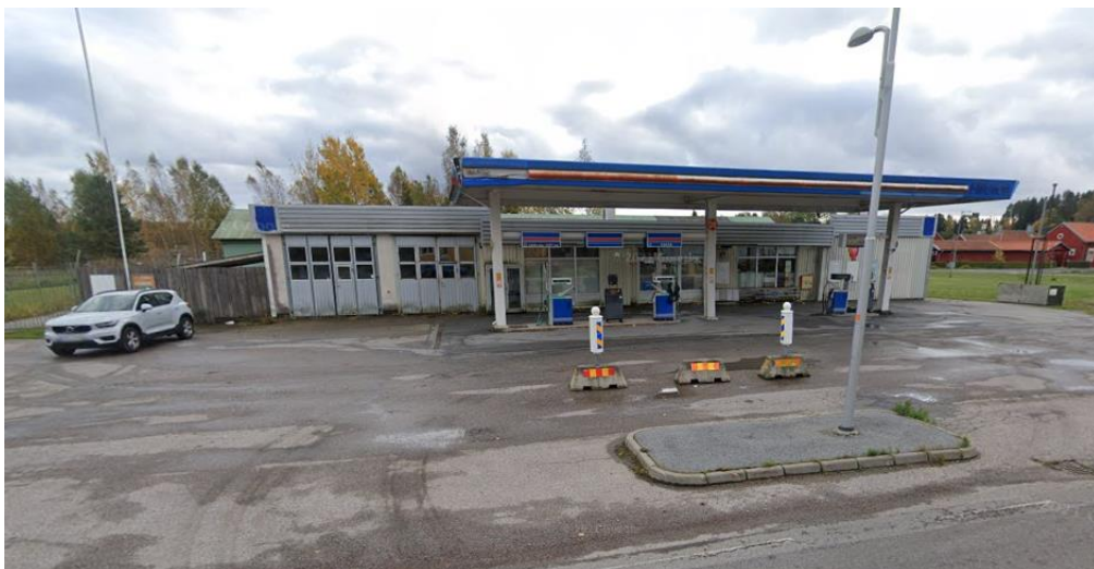
Figur 2. I befintliga bensinstationen inom planområdet finns enligt uppgift ingen verksamhet längre. Det är en förutsättning för risikanalyt att det inte kommer att finnas bensinstation inom planområdet.
