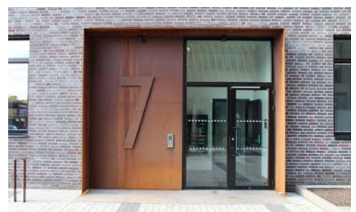
Övre: Exempel på uppglasat hörn. Nedre: Entré med omsorg i material och detaljering.
