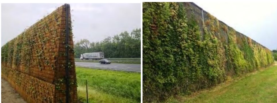
Referensbilder på bullerskärm uppförd som grön vegetationsvägg
