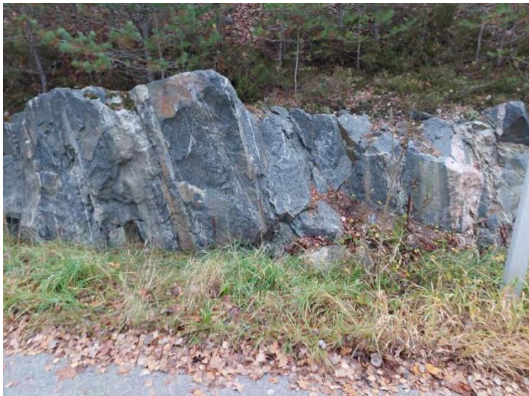
Figur 8.2 Låg bergskärning med granitisk gnejs och sliror av rosa granit.
