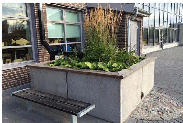
Figur 8-2. Upphöjd regnbädd ovan mark som även kan användas för till exempel plantering eller odling (Bara Mineraler 2019).
