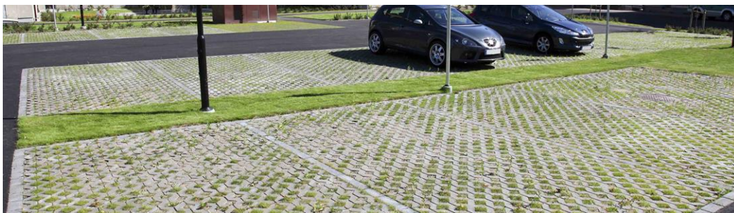
Figur 8-4. Parkeringsplats för bil utförd med gräsarmering som möjliggör för högre infiltration och mindre dagvattenavrinning (Benders 2019).
