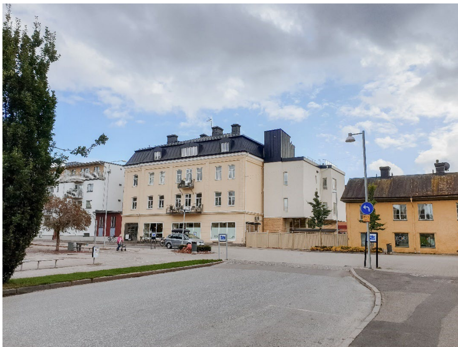
Platsanpassning i liten skala. Tillägg till bostads- och affärshus från 1907. Anpassningen till den ursprungliga byggnaden sker med ett modernistiskt formspråk. Den från gatan indragna volymen tar även hänsyn till kvarterets struktur och den etablerade sekvensen i gaturummet. Kv Hermelinen 7. Arkitekt: Bo Åhl (2018).
