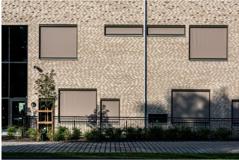
Detaljering tegel. Alphaskolan i Nyköping. Arkitekt: Carlstedt Arkitekter (2018)
