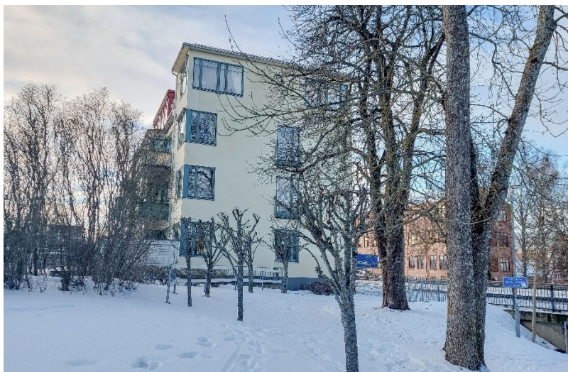
Detaljering puts. Kvarteret Varmbadet 18. Arkitekt: Södergruppen arkitekter (2003)
