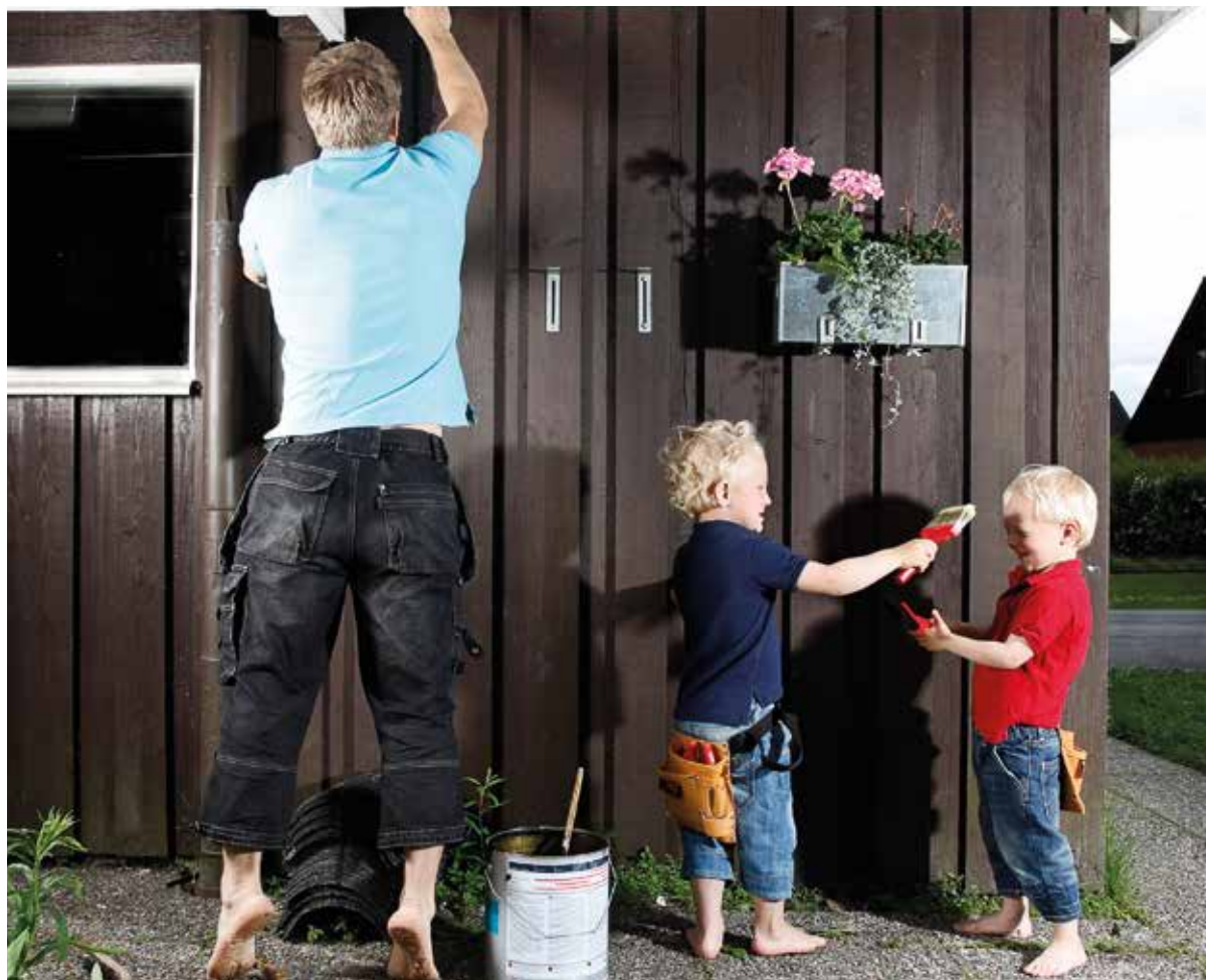
Det är inte solklart när bygglov behövs och inte. Kolla kommunens hemsida – och var redo att skicka in ritningar på det du ska göra.
