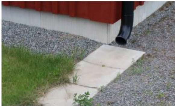
Figur 12) Vänster: Utkastare mot grönyta för infiltration. Höger: Skiss från Svenskt Vatten p105. Tak- och ytvattnet leds ut över mark. Överskottsvatten som inte infiltrerar kan ledas mot uppsamlade dräneringsstråk.
