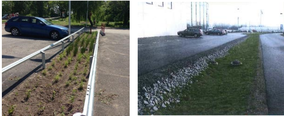
Figur 10) Dagvattnet från parkeringsytor kan ledas till infiltrationsstråk för fördröjning och rening.
