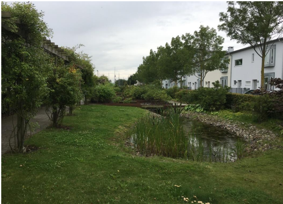
Bild 3 Öppen dagvattenhantering i kvartersmark, Lomma
