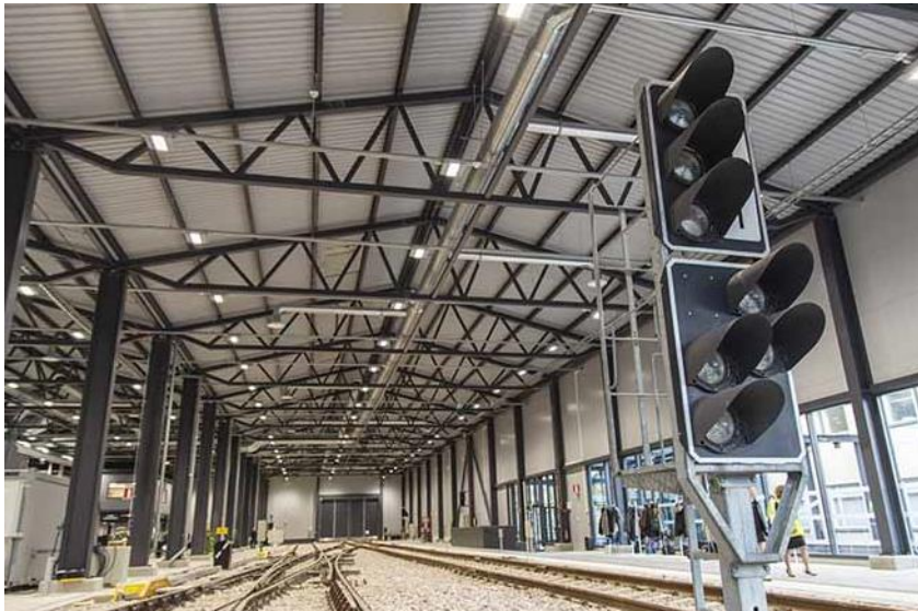
Figur 10. Övningsanläggningen i Finland är till stor del förlagd inomhus vilket ger en kontrollerad miljö. Källa: Järnvägstekniskt lärcentrum (vayla.fi)
