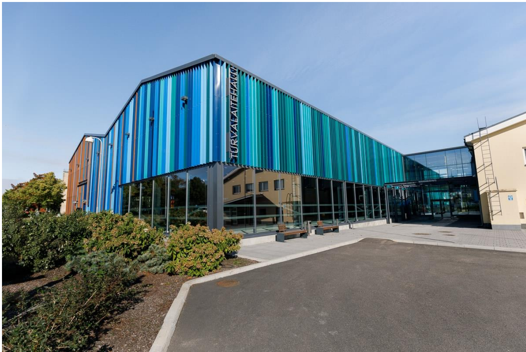
Figur 3. Foto på Järnvägsteknisk lärocentrums huvudbyggnad.
