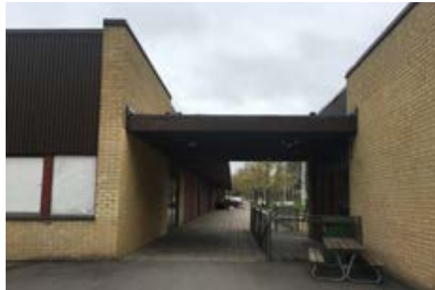
B. Vy mot befintlig länk mellan annex och butik (till vänster)
