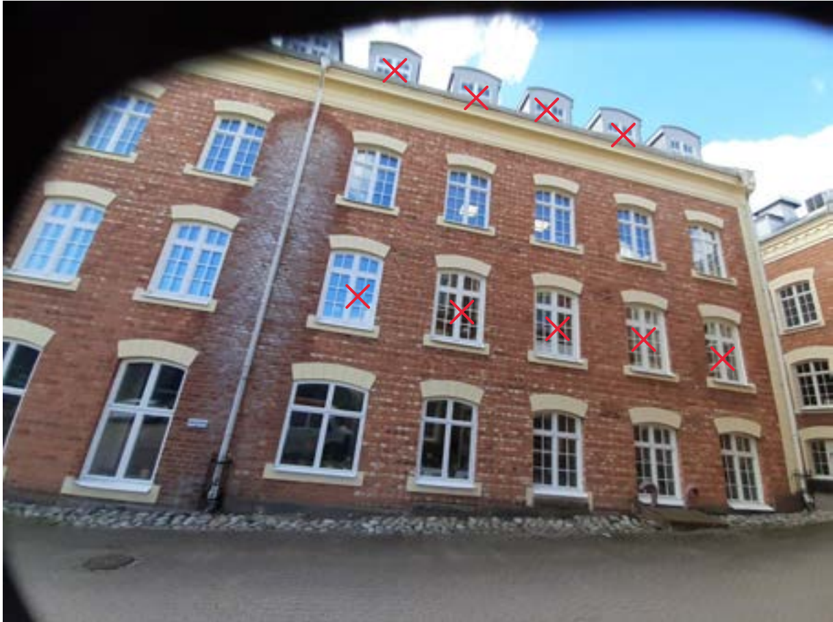
Foto 8, sektion 2 (höger om stuprännan)
