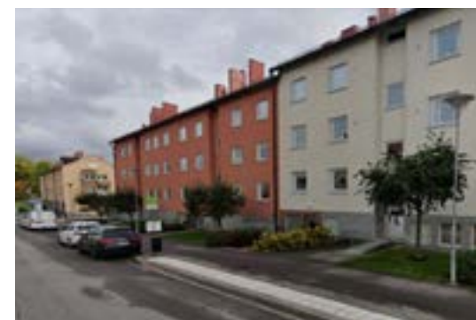
5. Referens putskulör på befintliga fasader i Gamla Oppeby
