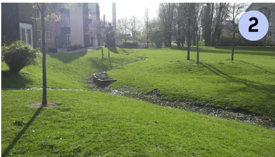
Bild 2 visar förslag på utformning av multifunktionell skyfallsyta.
