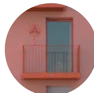
12. Öppna räcken ton i ton med fasad
