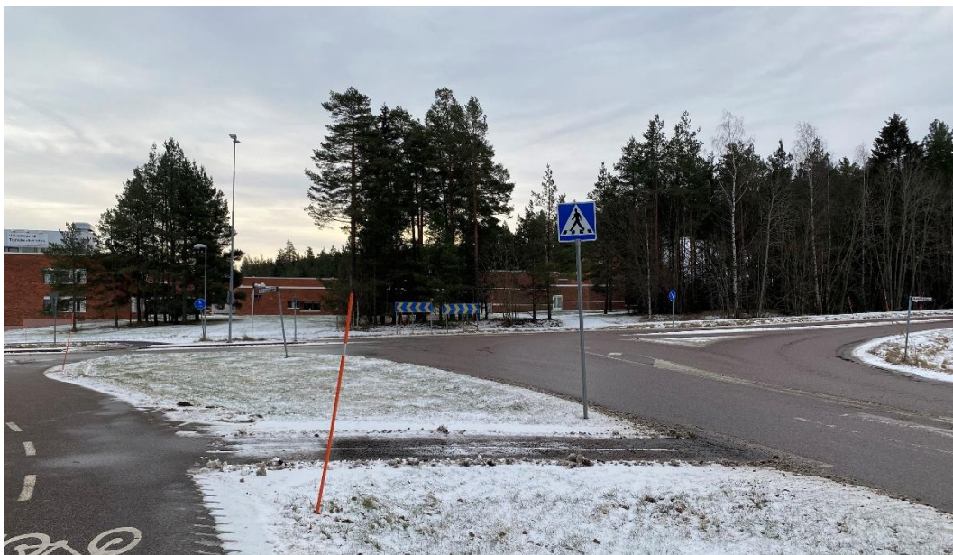
Foto över befintlig vägkorsning som planeras att byggas om till cirkulationsplats med fastigheten Produkten 1 på andra sidan.
