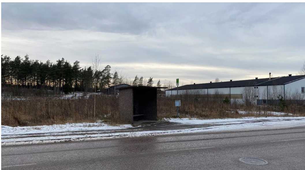
Foto över befintlig busshållplats på västra sidan av Arnöleden som planeras att byggas om med en bussficka vid hållplatsen.
