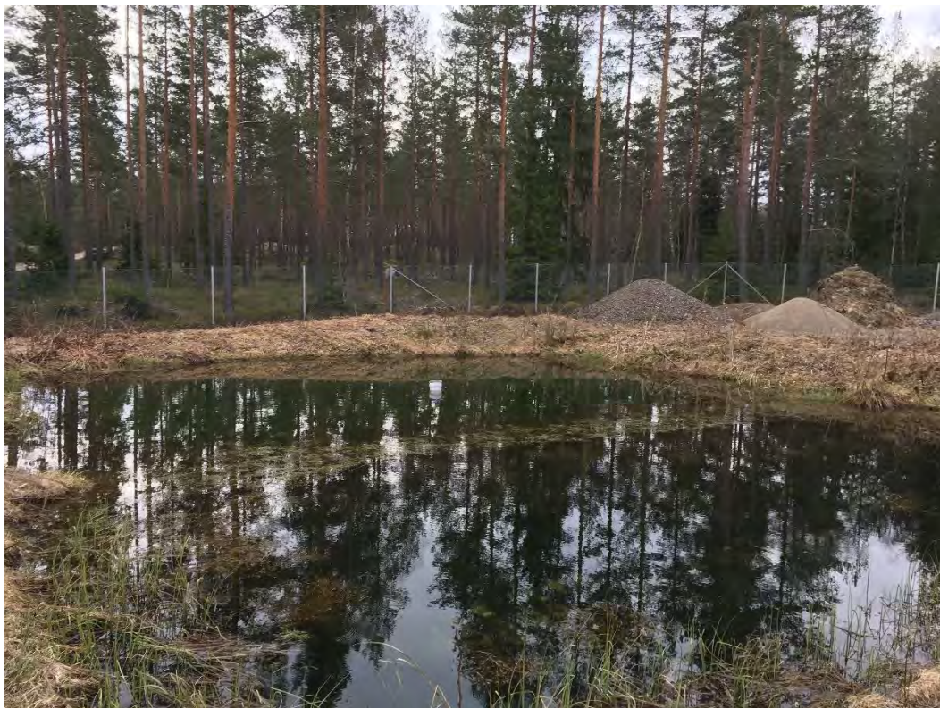
Foto 2.1 – Infiltrationsdamm vid Stavsjö vattentäkt.
