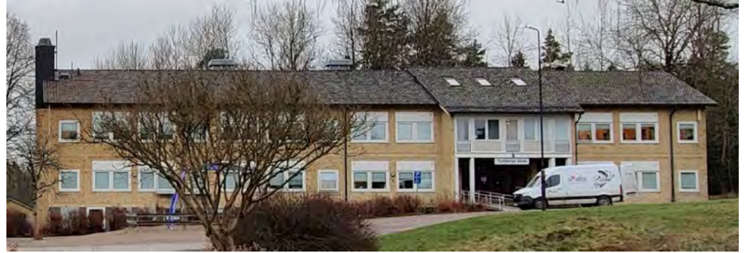
FOTO BEFINTLIG FASAD MOT SÖDER
