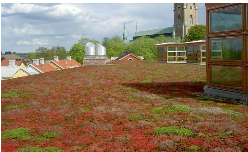
Figur 18 Sedumtak på stadsbiblioteket i Linköping ( www.vegtech.se )
