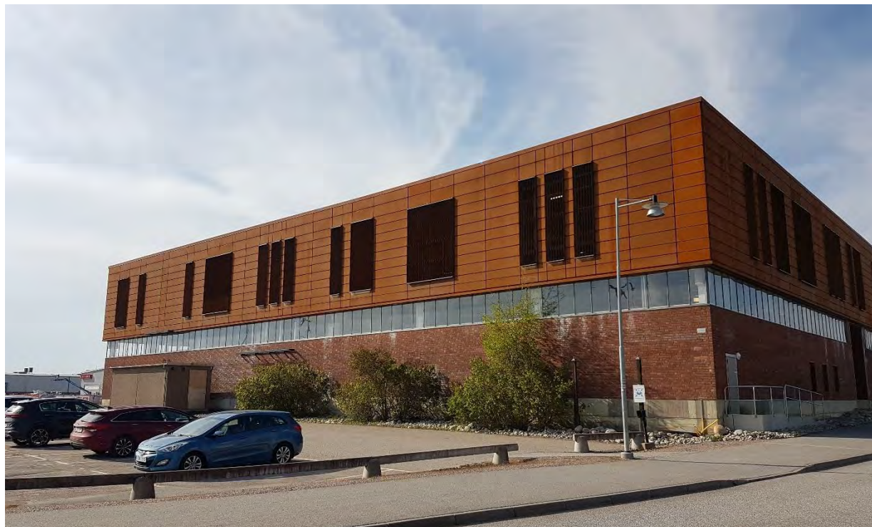
Byggnad P6, med ny fasad i cortenstål, sedd från bostadsområdet i norr.
