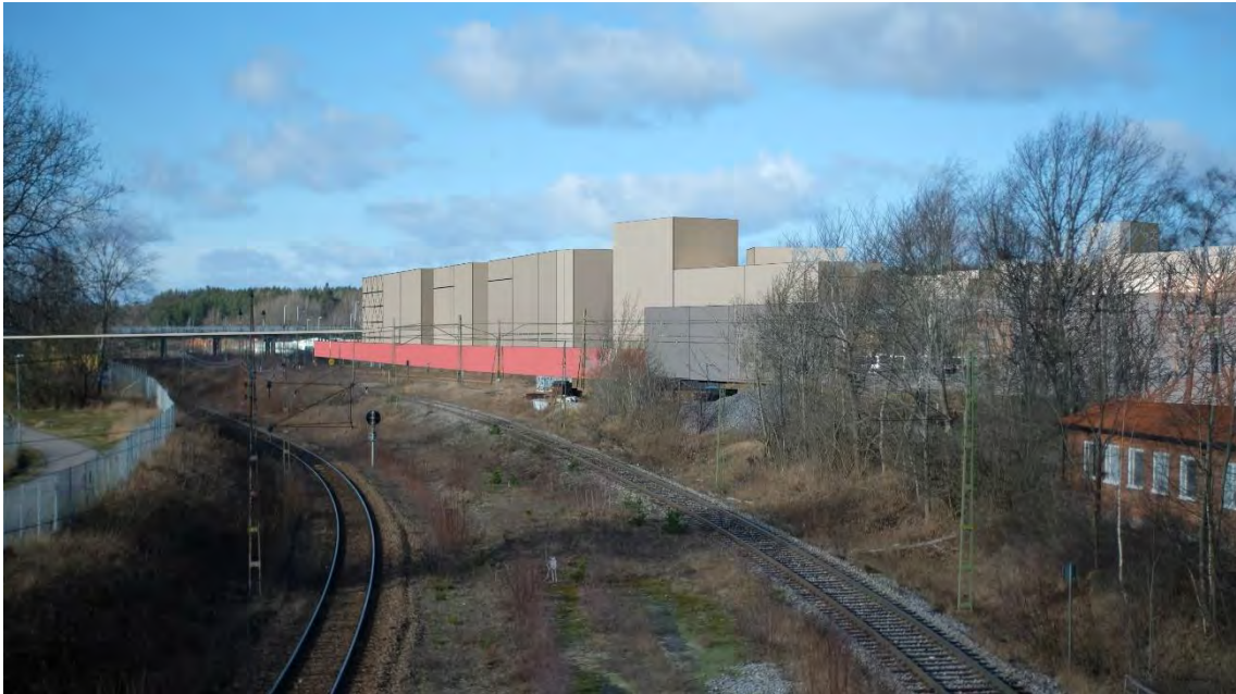
Figur 8-8: Visualisering vy från gångbron sydväst om stationen. Bullerskärmen är rödmarkerad. Påverkan på stadsbilden bedöms vara mycket begränsad.
