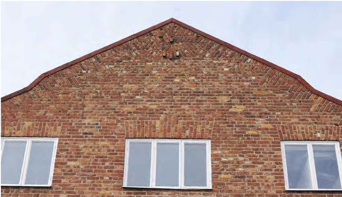
Figur 8-6. Den före detta charkuterifabriken på slakteriet (Raspen 2). Trots fönsterbyten har byggnaden en distinkt nationalromantisk arkitektur likt de samtida byggnaderna stationen, tingshuset och Odd Fellow-huset i Nyköping. Foto: Mattias Eklund 2017.
