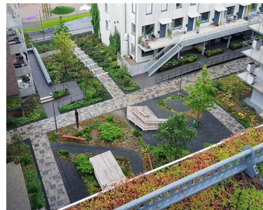
Sumpskogsinspirerad innergård där dagvatten ses som resurs, Kv Stora Sjöfallet, Norra Djurgårdsstaden, Urbio
