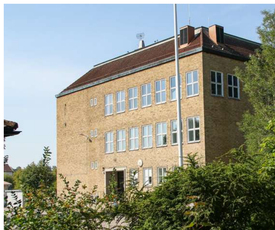
Befintlig tegelbyggnad. Släbroskolan, Nyköpings kommun
