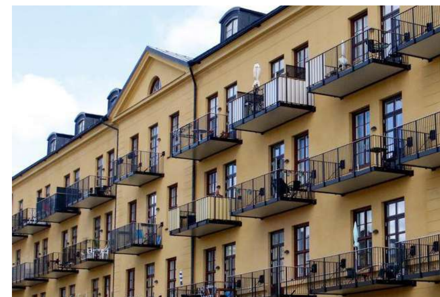
Konvertering av kasernbyggnad till trygghetsboende. Hågesta, Sollefteå. Gisteråsjöstrand arkitekter, foto Allehanda
