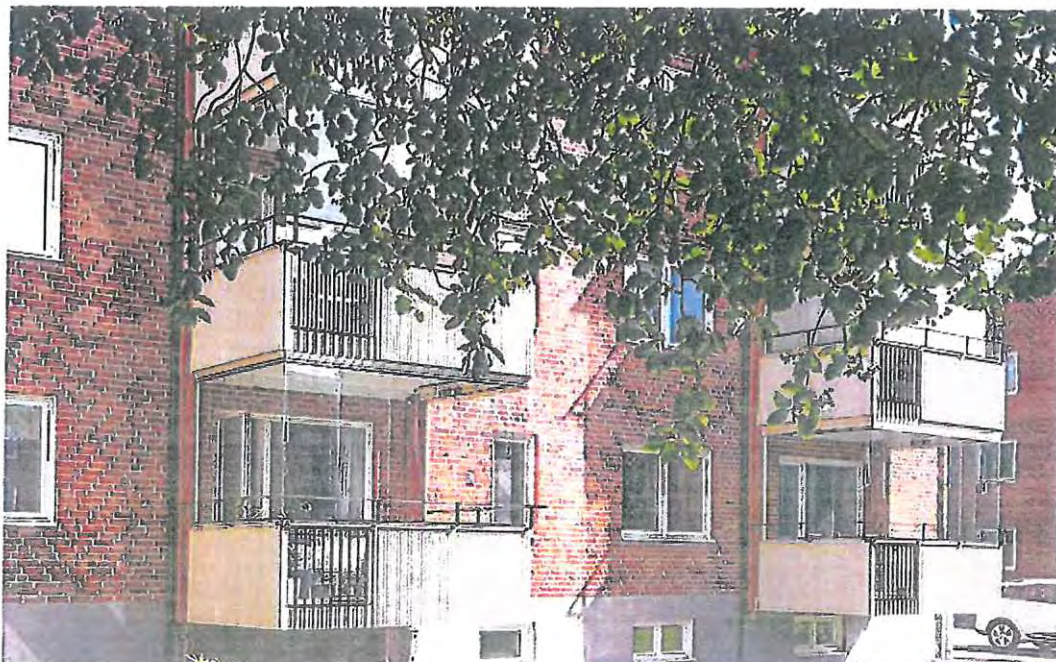
Balkongprojekt Balco Brf Tackan, Gethornskroken i Hässleholm Byggår: 2017
