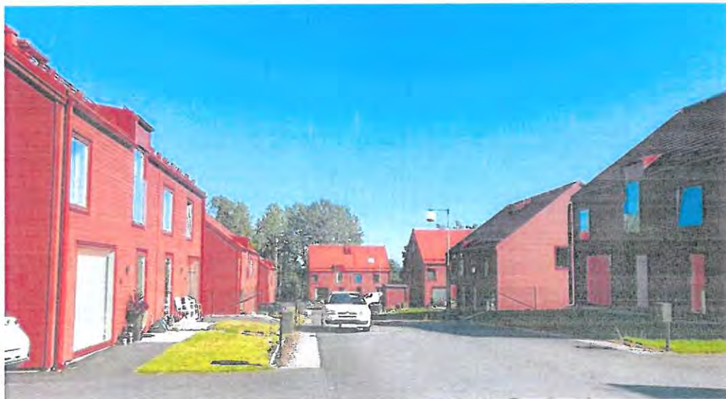
Bild 3: Byggnader på Oboen 1, foto: Anna H/Bygglovenheten
