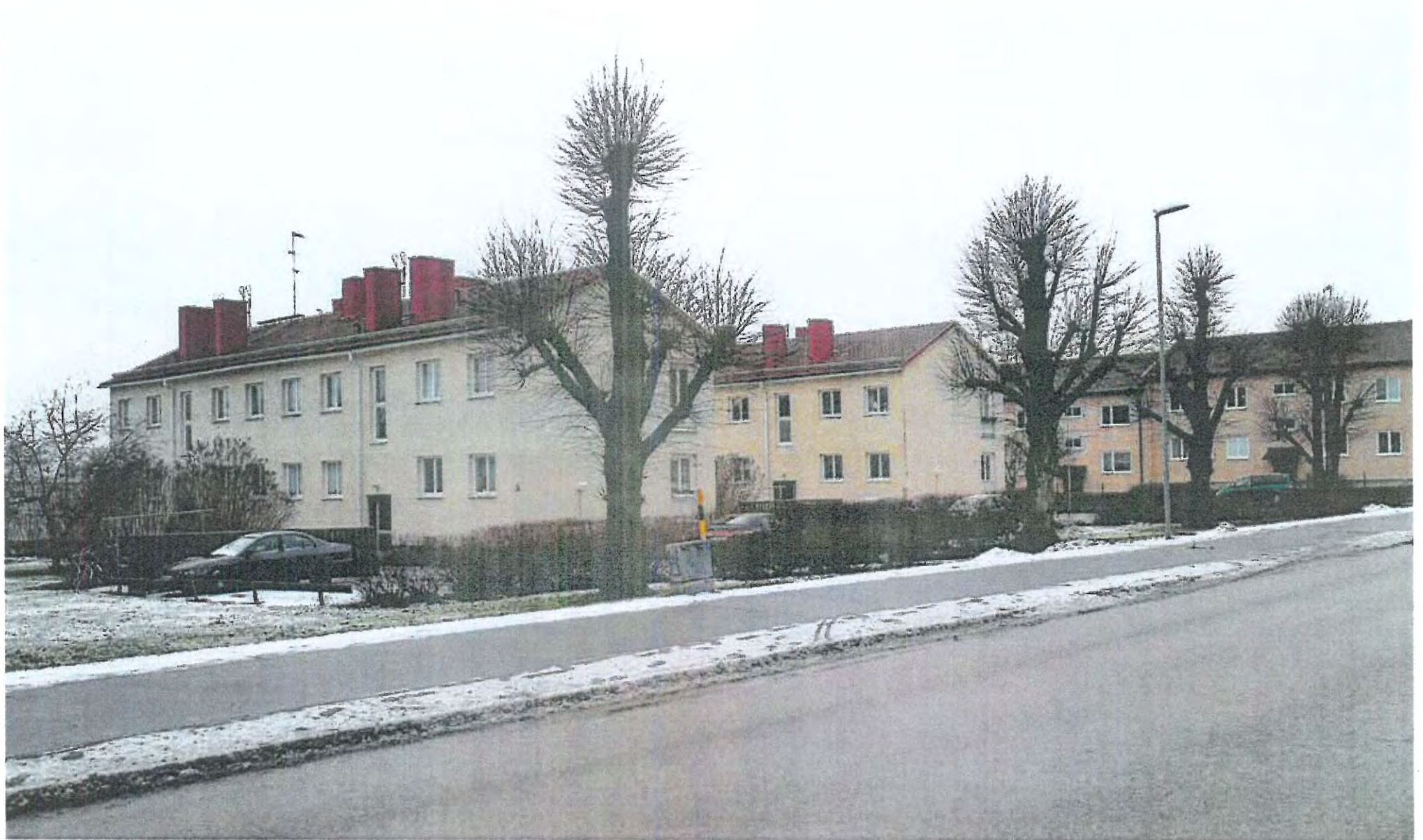
Lamellhus med sadeltak är en än vanligt förekommande byggnadstyp i området
