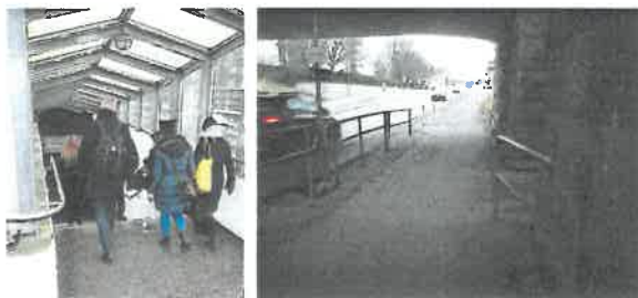
1. Östra nedgången från plattform. En tydlig riktning som leder ner under bron vid Brunnsgatan. Brofästet längs Brunnsgatan har en vacker stenkonstruktion och med vissa ljusinsläpp från taket. Tyvärr är krockrisken mellan fotgängare och cyklister stor, miljön är bullrig och luften känns instängd.
