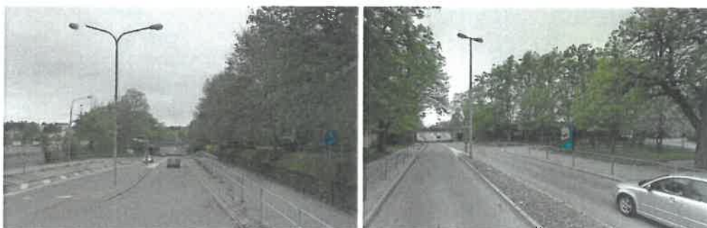
Figur 33. Brunnsgatan vy mot norr med järnvägsområdets öppna grusytor till vänster och kyrkogårdens grönska till höger. Brunnsgatan vy mot söder med platsbildningen i korsningen Norra Bangårdsgatan till höger och med Folkungavallen till vänster.
