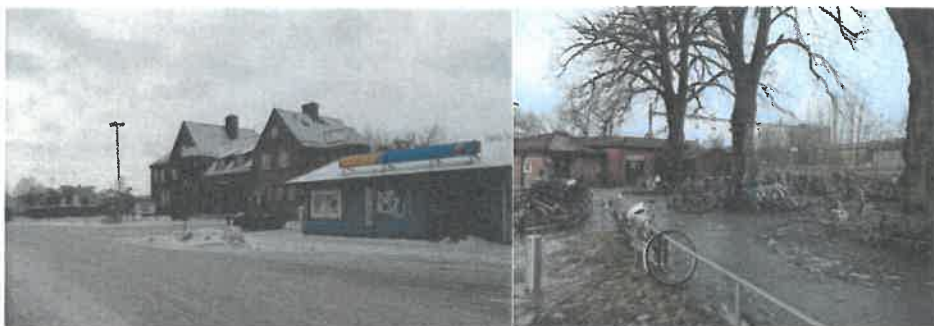
Figur 31. Centralplan med det vackra stationshuset i fonden är stor, rörig och svårorienterad.
