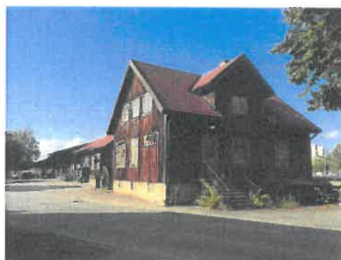
Figur 39. Godsmagasinet. Foto Sweco.
