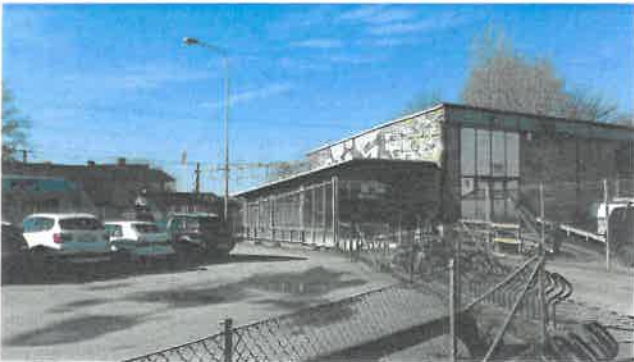
2. Vy söderut över plats för norra uppgången från tunnel under spåret. Gott om cykel-parkeringsplatser som inte används. Vägen fram till trappan domineras av hårdgjorda ytor som förstärker transportrummet, stängsel utan gestaltningskvaliteter som blir exkluderande och trånga passager samt nedgångna industrimiljöer där byggnader ändå har vissa grundläggande kvaliteter i material och komposition. Det här är en plats som trots kort metriskt avstånd till centralplanen upplevs relativt långt bort.
