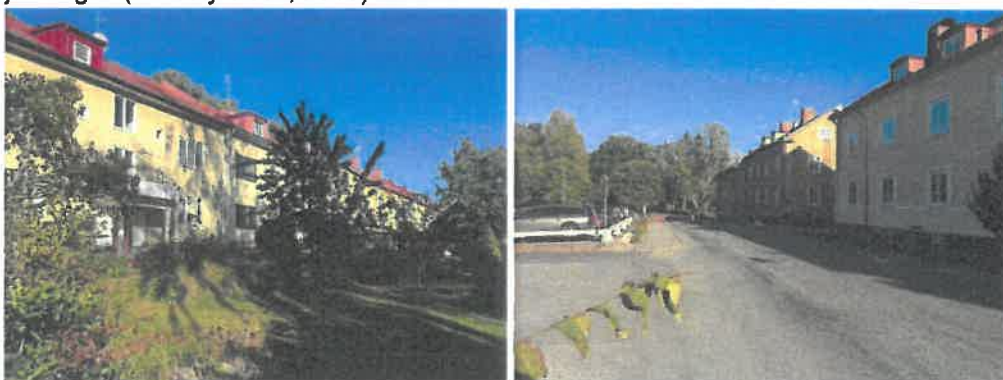
Figur 36. Kvarteret Skrivaren och Konduktören omsluter ett inre grönt trädgårdsrum (till vänster). Bostadshusen bildar en enhetlig bebyggelsefront mot Södra Bangårdsgatan (till höger). Foto Sweco.
