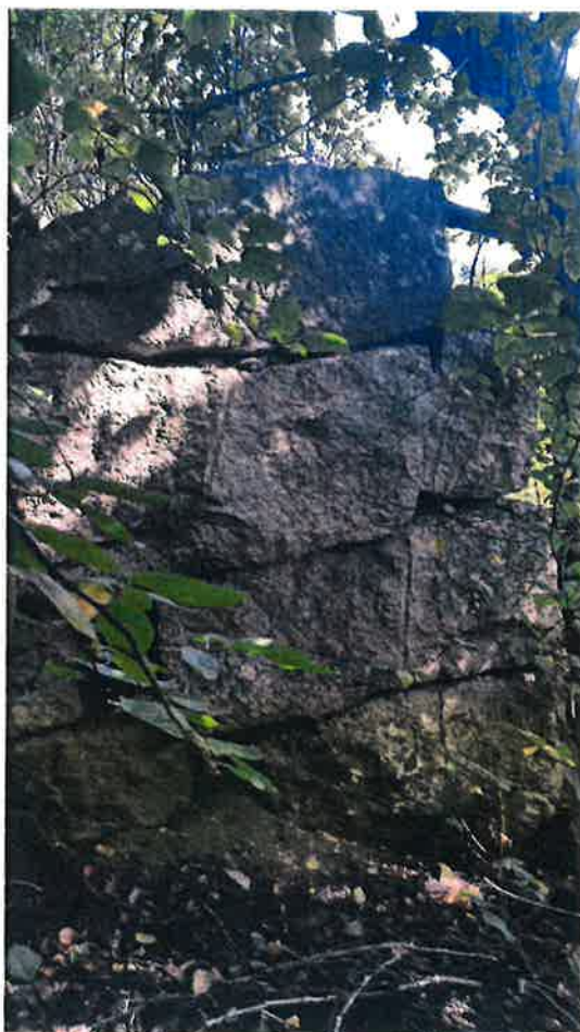
Brofundament väster om ladan
