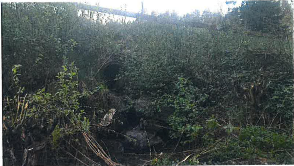
Dagvattenkulvert under Trädgårdsångarvägen
