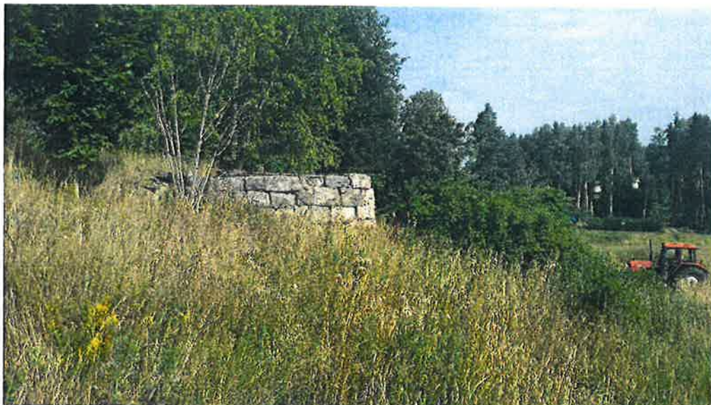
Brofundament söder om ladan
