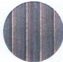
Fasadtyp 2. Träpanel med lock i två dimensioner.
