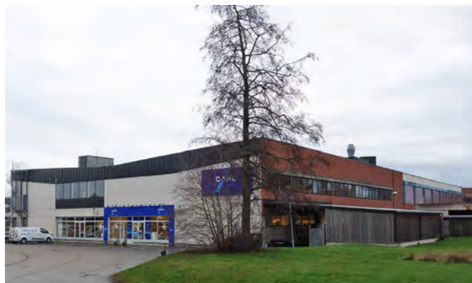
Befintlig byggnad, nordvästra fasaden.
