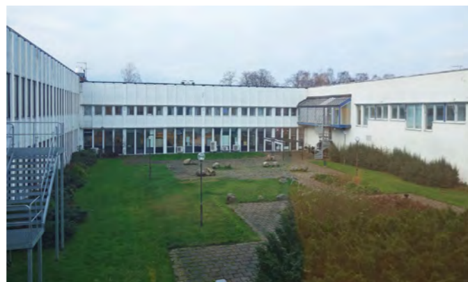
Innergård befintlig byggnad.
