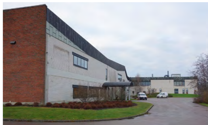
Befintlig byggnad, norra fasaden.
