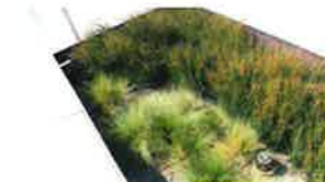
Exempel på ekologisk dagvattenhantering med fördröjning och rening av dagvatten genom grönytor.
