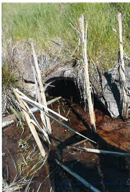
Figur 15) Befintlig dagvattentrumma under Katrineholmsvägen (från platsbesök i maj 2018). Foto: Sara Johansson, WSP, 2018
