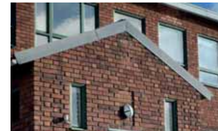
Wedholms kontorsbyggnads fönster och indragna fogar beaktas.
