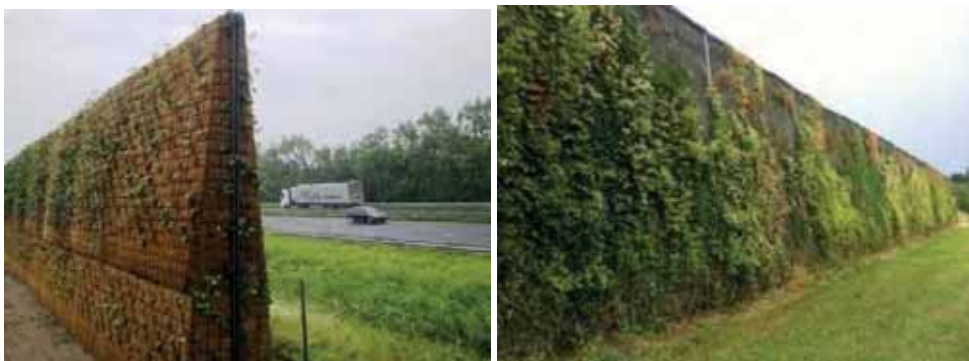
Referensbilder på bullerskärm uppförd som grön vegetationsvägg
