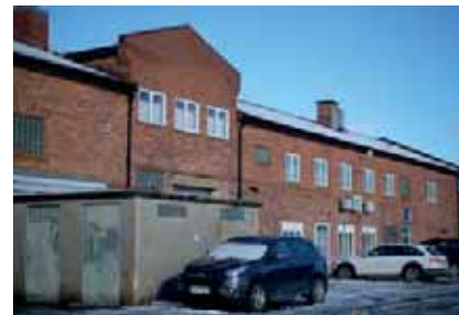
Försvunna kvalitéer får möjlighet att återskapas.
