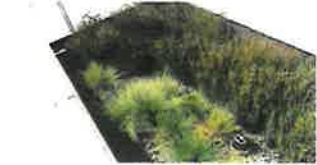
Exempel på ekologisk dagvattenhantering med fördröjning och rening av dagvatten genom grönytor.
