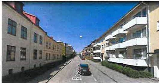
Utanpåliggande balkonger på nyare byggnader (Bagaregatan)
