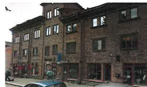
Sockelvåning med skyltfönster (Västra Trädgårdsgatan)
